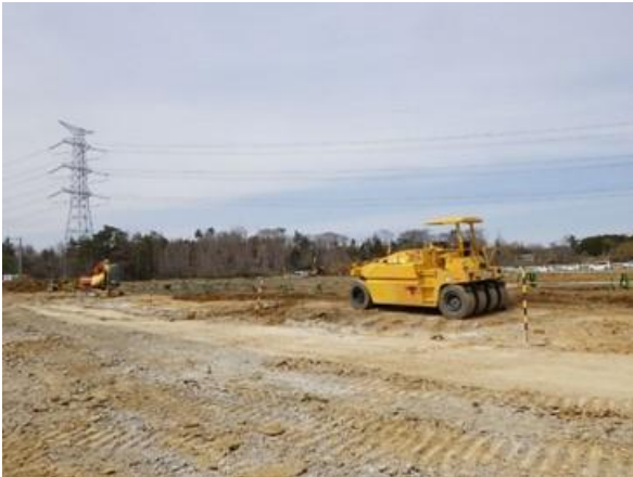
H29.4 (杭打設工事準備)
