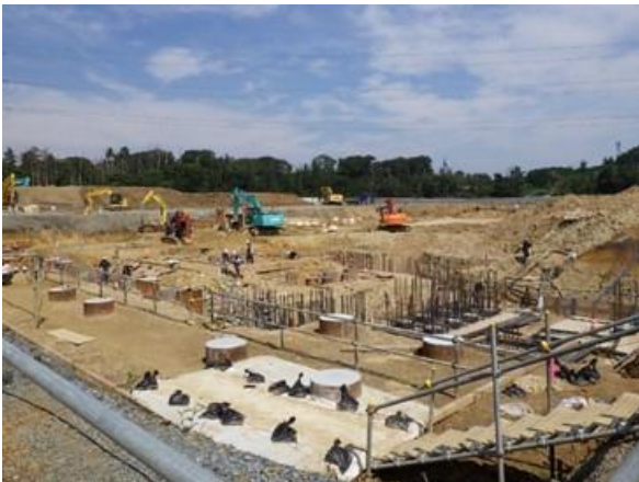
H29.8 (基礎工事)
