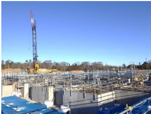
H29.12 (基礎工事)
