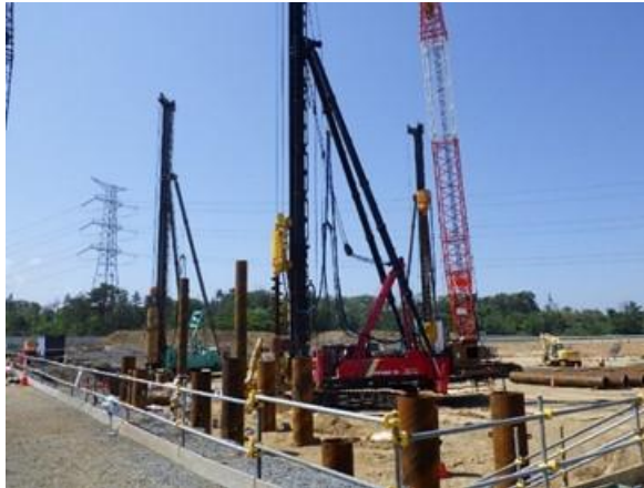
H29.5 (杭打設工事)
