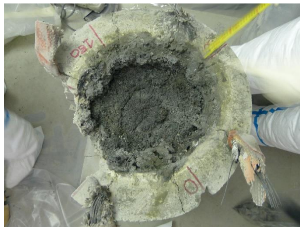
解体前の状況(上部筒撤去後)
