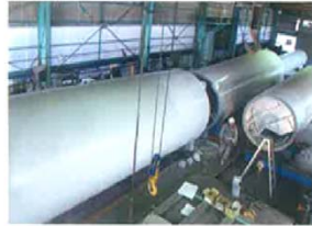
■タワーの塗装
