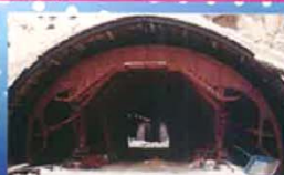
■トンネル型枠
