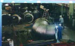
■下水道管(東京都)
