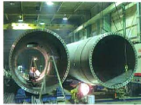
■タワーの製作
