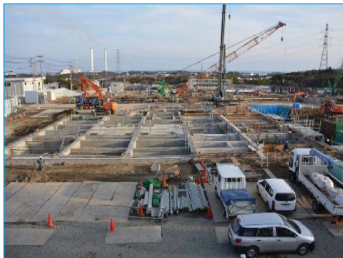
③研究管理棟：コンクリート基礎の状況
