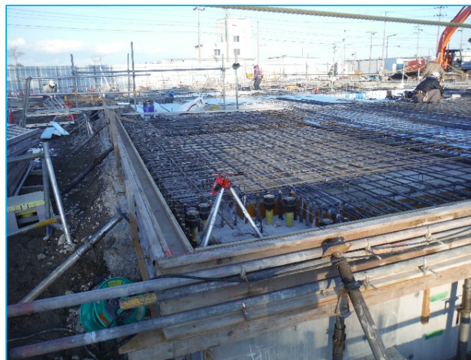
④研究管理棟：コンクリート打設状況
