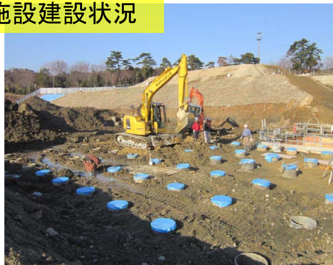
②試験棟：杭打完了部分の状況
