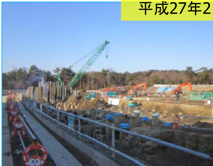
①試験棟：杭打工事の状況
