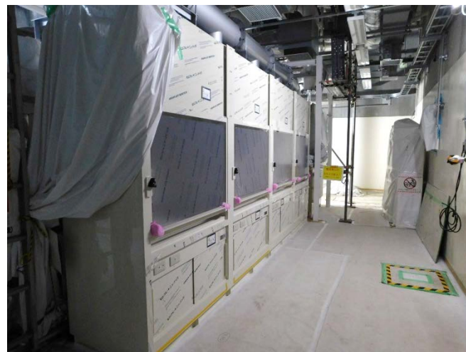
フード室 整備状況 (2020.10)
