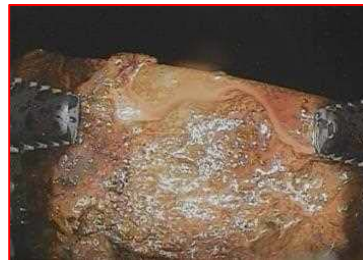
プラットホーム ペDESTAL底部
