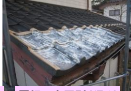
屋根の表層剥ぎ取り
