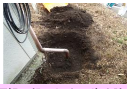
雨樋下部のホットスポット除去
