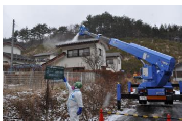
屋根の高圧水洗浄
