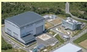
楢葉遠隔技術開発センター
