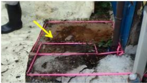
雨樋の出口付近
