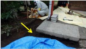
コンクリート等のきわ
