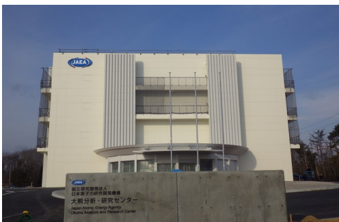
完成した施設管理棟（2018年4月運用開始）
