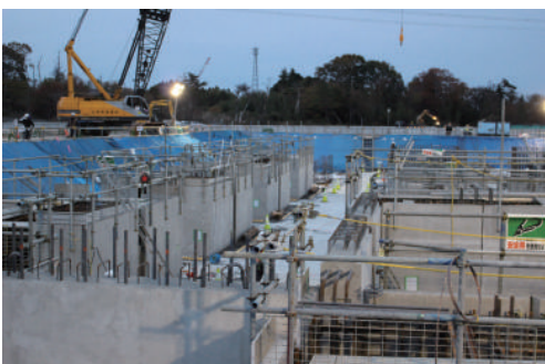
第1棟の建設の様子（2017年11月）
