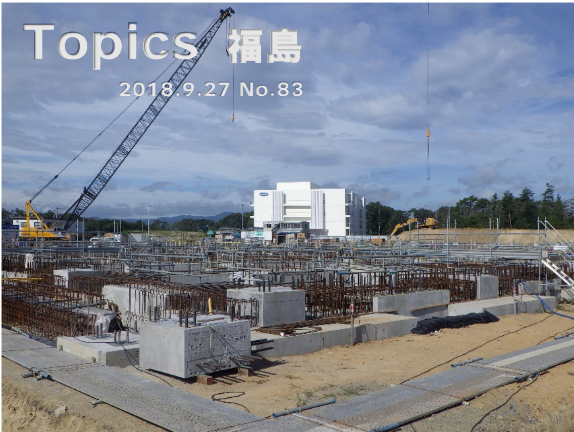
第1棟の建設状況(中央奥の建物は施設管理棟)
