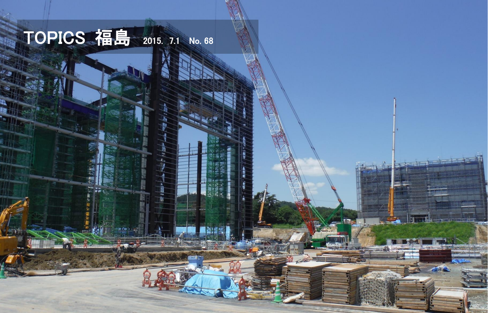
楢葉遠隔技術開発センターの建設現場。右奥が研究管理棟。左手前が試験棟。 (広角レンズ撮影)
