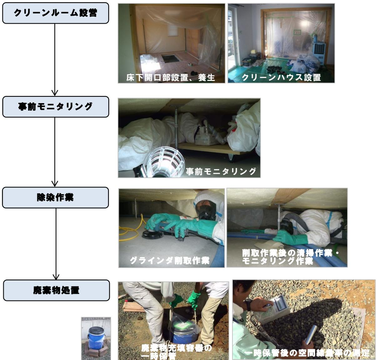
研削粉は集めたことにより、線量が高くなっているため、遮蔽用の容器に入れ、ご自宅のお庭に穴を掘って一時保管させていただきます。
