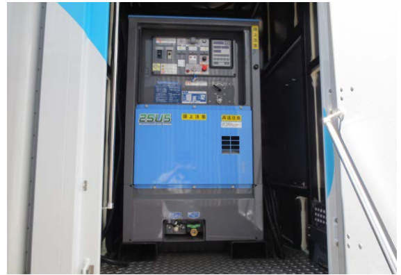
発電機は隔離され、振動や騒音が直接伝わらない設計
