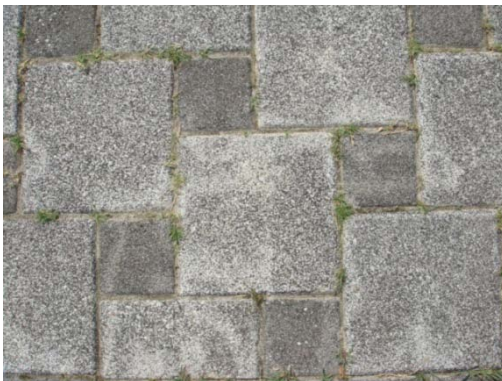
図3 除染前後の全景(上段)と表面状態(下段)。左列は除染前、右列は除染後。除染により目地砂は回収されてしまうため、除染後白い目地砂を入れている。
