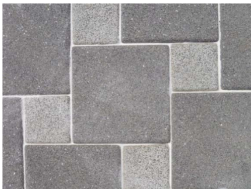
図3 除染前後の全景(上段)と表面状態(下段)。左列は除染前、右列は除染後。除染により目地砂は回収されてしまうため、除染後白い目地砂を入れている。
