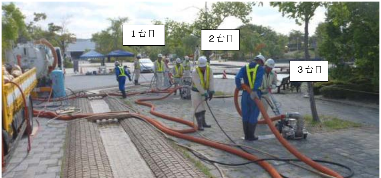
図1 3台の洗浄機で同時に除染することで作業効率を3倍に向上できることを確認 ※ただし、表面汚染状況、作業場所等によって効率は変化する。
