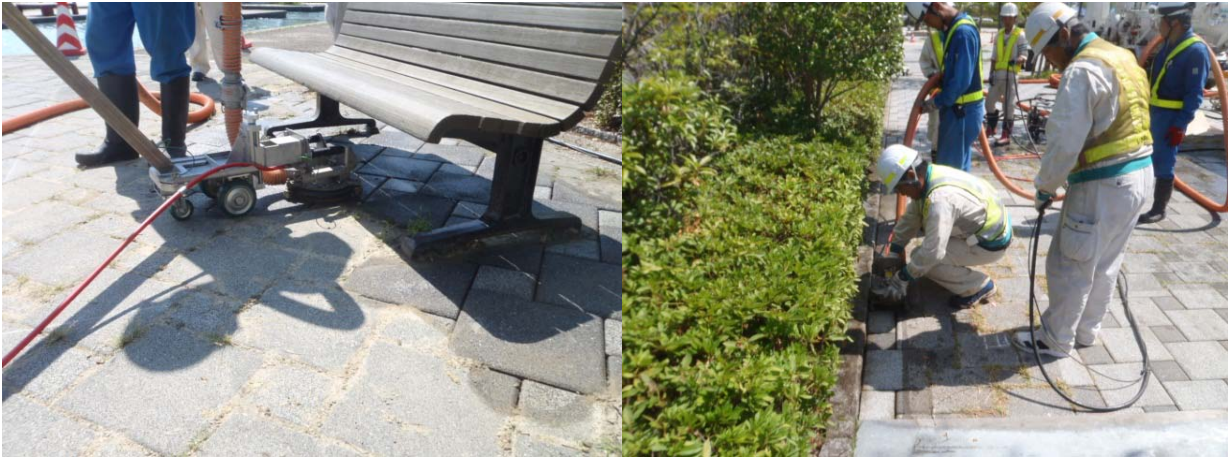
図2 既存洗浄機では除染できなかったベンチ下や端部の除染をできる小型洗浄機を開発
