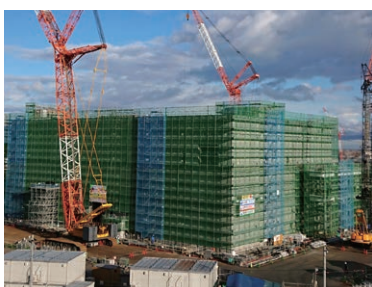
建設が進む第1棟（2019年11月撮影）
