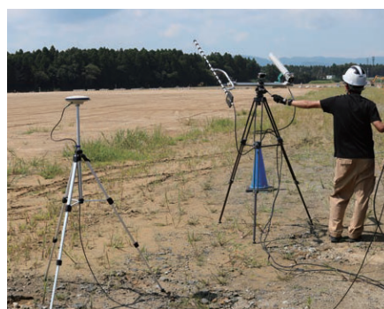
地局の設置風景
