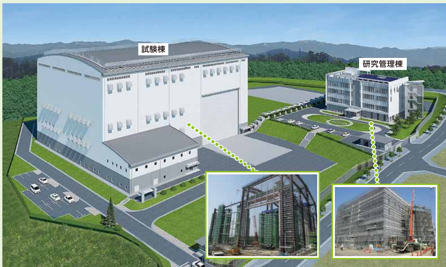
楢葉遠隔技術開発センターの完成イメージと建設状況(2015年6月撮影)
