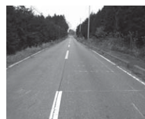
アスファルト
