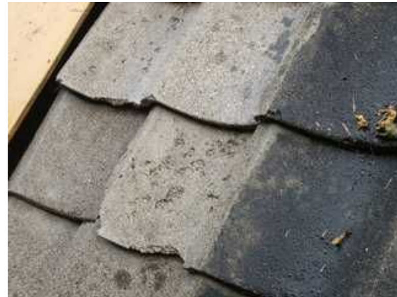
セメント瓦 (左側 除染後)
