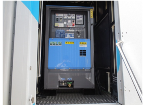
発電機は隔離され、振動や騒音が直接伝わらない設計
