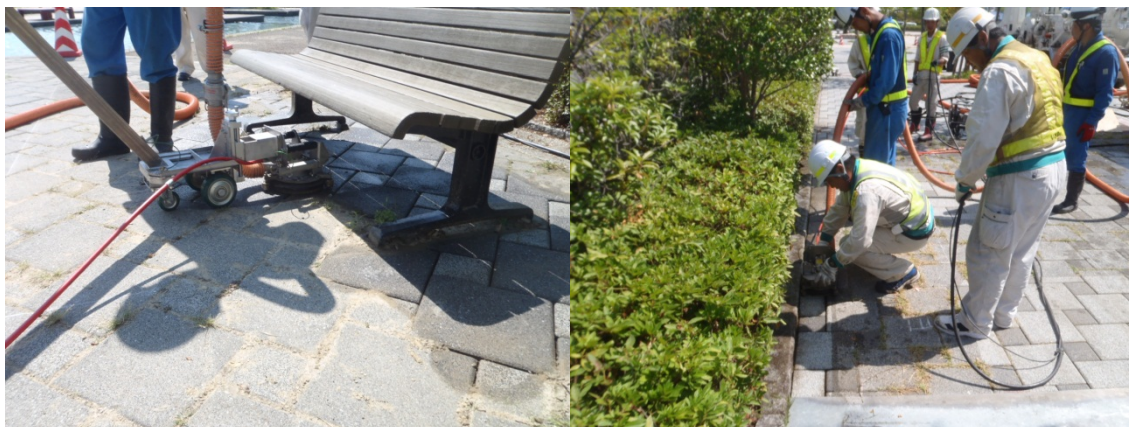
図2 既存洗浄機では除染できなかったベンチ下や端部の除染をできる小型洗浄機を開発
