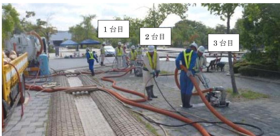
図1 3台の洗浄機で同時に除染することで作業効率を3倍に向上できることを確認 ※ただし、表面汚染状況、作業場所等によって効率は変化する。
