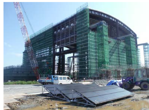
建設中の試験棟
