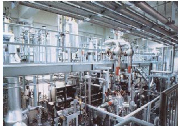
重水精製装置 I (現在は解体済)
