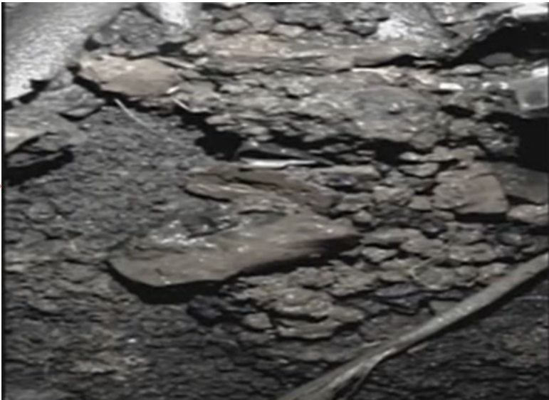
2号機 ペDESTAL底部に堆積した燃料デブリの外観 [1]
