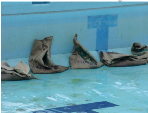
麻袋内の汚泥の水抜き
