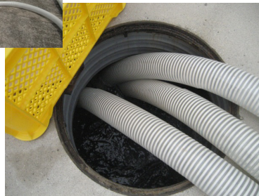
排水用のマンホールにホースを挿入
