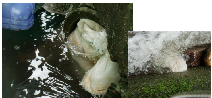
①側溝側の導管入口部を土嚢でふさぐ
