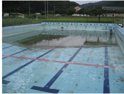
作業後のプール
