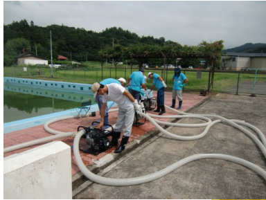
ポンプ3台を利用
