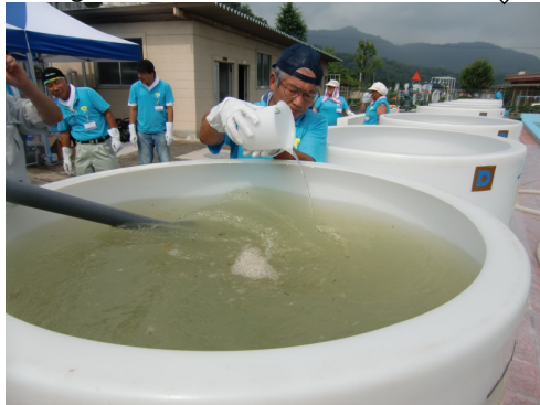
ポンピングにより残水を1tタンクに注入後、水が 攪拌されている状態でPAC(凝集剤)を注入
