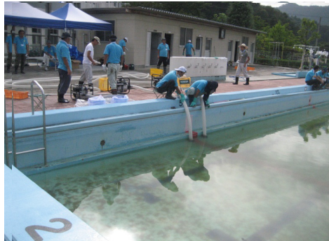
中型ポンプ2台で排水
