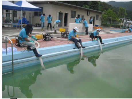
ポンプ3台で排水
