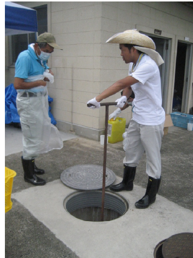
滞留水の放射能濃度がN.D.であることを確認後、バルブを操作し、排水口から水を流し、排水管を洗浄。
