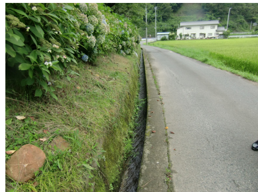
排水する側溝
