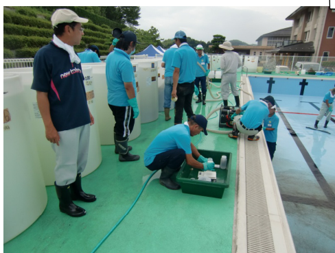
洗浄水を1tタンクに回収、凝集・中和処理。
