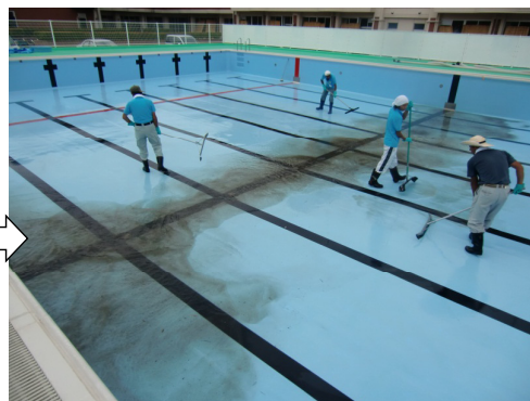
プール底表面を洗浄。
