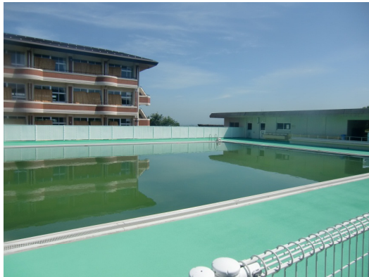
作業前のプールの状況
