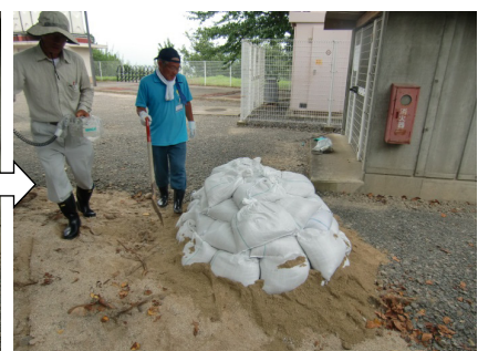
土嚢を載せて、砂で覆って作業終了！ (麻袋15個、土嚢20個)
