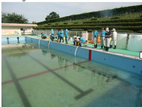
ポンプ3台で排水。
