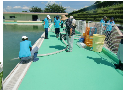
ポンプの設置作業
