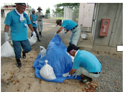
ブルーシートを被せ、土嚢で固定。
