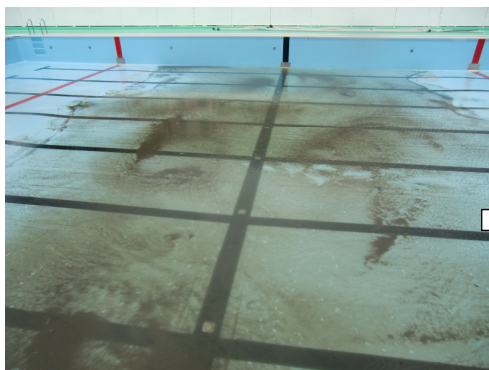
排水作業により、汚泥がプール底表面に露出。
