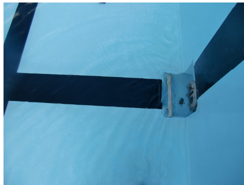
汚泥を除去後の排水口。
