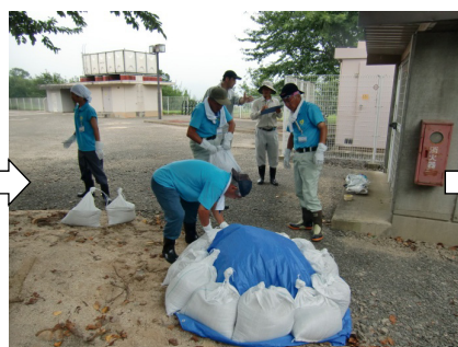
ブルーシートを被せ、土嚢で固定。
