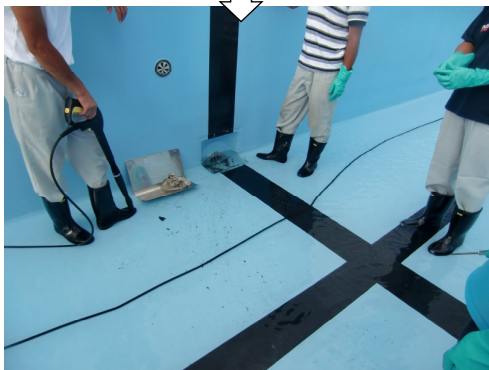
高圧洗浄水で配管内を洗浄。漏出してきた汚泥を除去。
