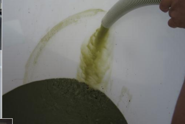
汚泥を含むプール水の排出の様子
