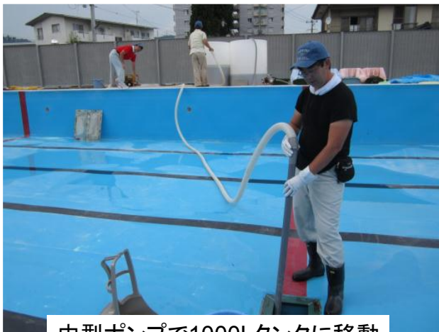
中型ポンプで1000Lタンクに移動 枯葉類は移植ごてでザルで濾す
