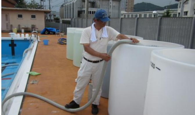
汚泥を含むプール水(約6t)を1tタンクへ移動
