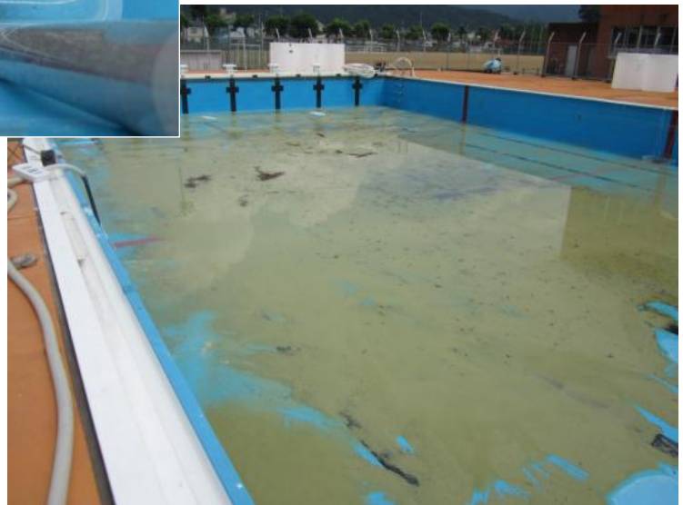
排水作業直後の プール底の汚泥の様子 (汚泥量約6t)
