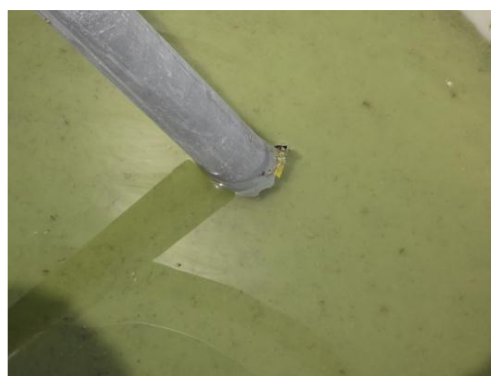
上澄み排水の状況 写真上は小型ポンプ使用時
