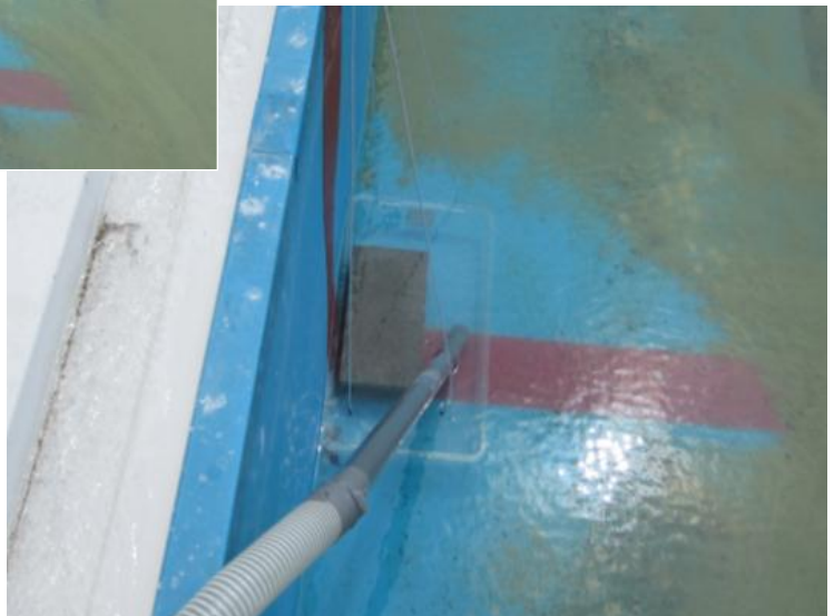
中型ポンプで排水
