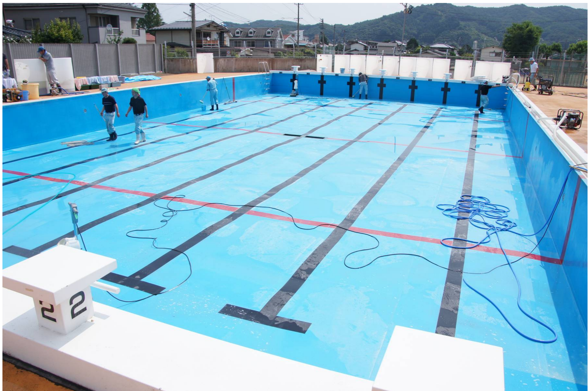
学校側作業員によるプール全体の本格的な清掃 (110727)
