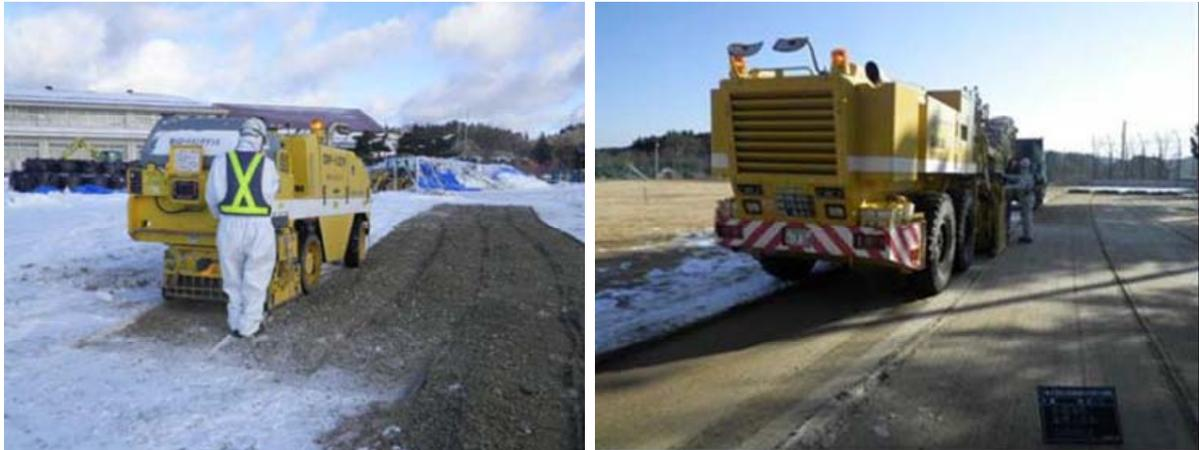
舗装面の切削工法の一つとして、TSファイン・ミリング工法がある。通常の切削ドラムが15mm間隔でビットを配列しているのに対して、TSファイン・ミリング工法は、6～8mm間隔の細密切削ドラムを装備した切削機である。通常の切削工法よりも、切削厚さにムラのないきめの細かい切削が可能となる。
