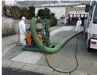
コンクリート土間: ショットブラスト
