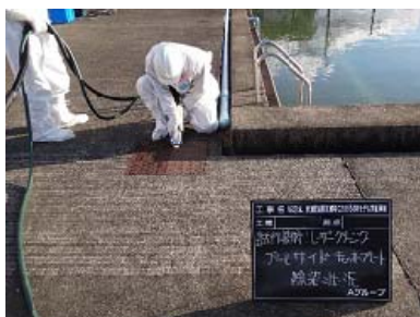
レーザーアブレーション※1によるチェッカープレート面※2の除染
