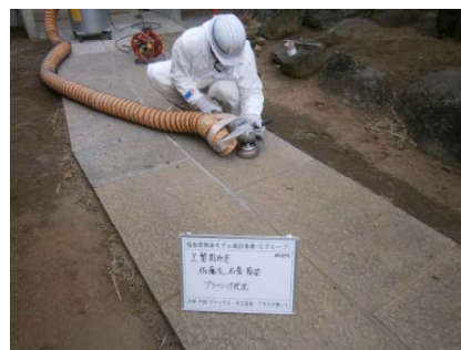
宅地: カップブラシ*による石畳の削り取り
