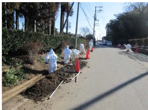
人力による側溝の清掃
