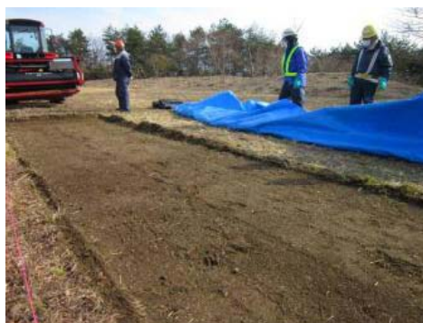
ターフストリッパー※による表土剥ぎ取り
