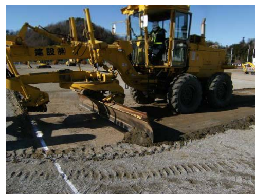
搭乗式清掃機による表土剥ぎ取り
