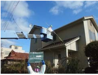
屋根: 水洗浄、ブラシ洗浄
