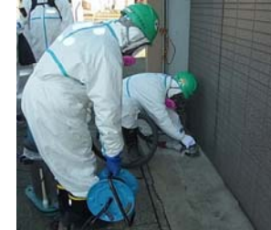
コンクリート土間: 表面研磨機
