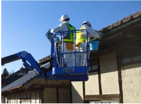
高圧洗浄による壁面清掃
