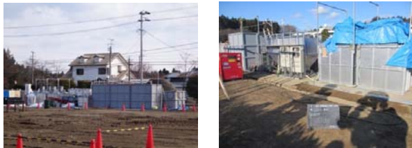
〈水処理設備設置状況〉
