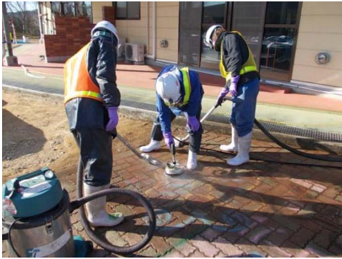
インターロッキングの高圧洗浄(回収型)
