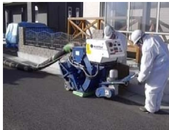
スチールショットブラストによる切削 (アスファルト舗装)
