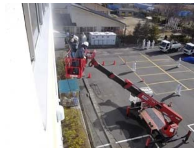
高圧水洗浄による壁面清掃
