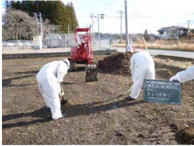
重機・人力による表土剥ぎ取り
