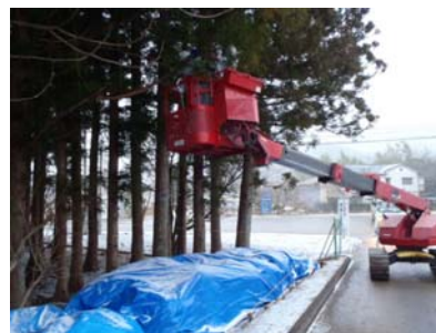
高所作業車による枝葉等の除去
