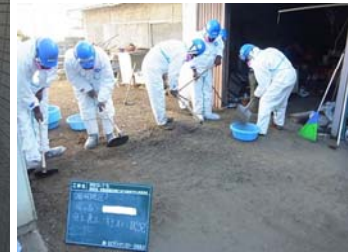
庭: 表土の剥ぎ取り
