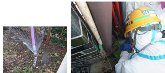
雨樋(縦樋): 高圧水洗浄、吸引
