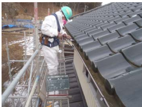
高圧洗浄機による壁面清掃
