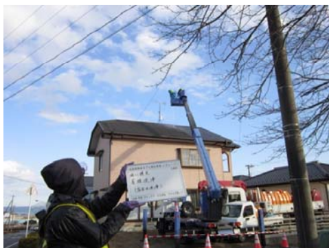
屋根の高圧洗浄
