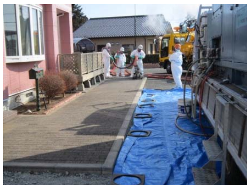
超高圧水(約200MPa)洗浄機による インターロッキングの洗浄
