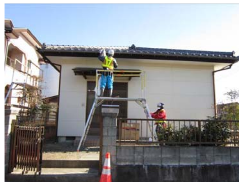
人力による雨樋の清掃
