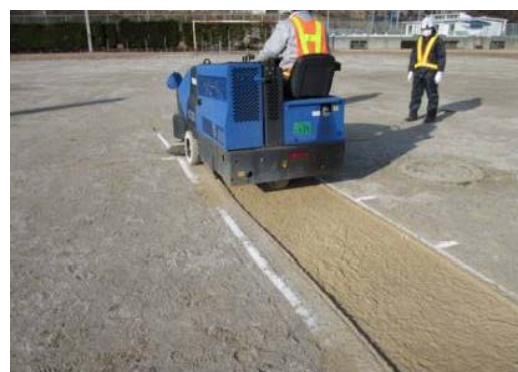
搭乗式清掃機による表土剥ぎ取り
