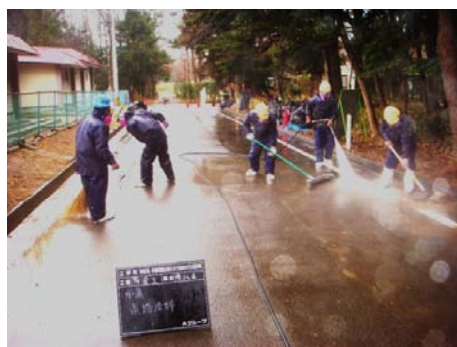
人力による高圧水洗浄
