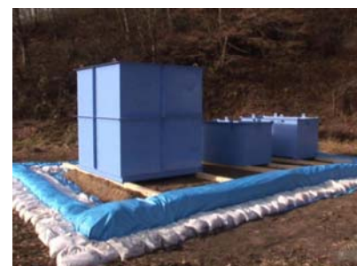
〈洗浄水集積水槽(集会所に設置)〉 8 m 3 水槽×1基
