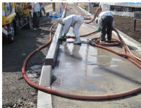
超高圧水(約200MPa)洗浄機による 歩道の洗浄
