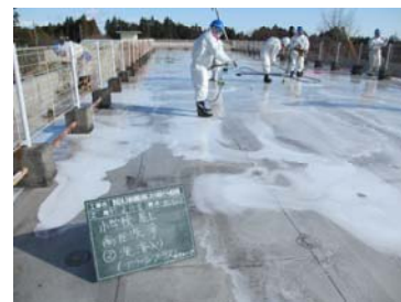
中性洗剤を併用した試行洗浄
