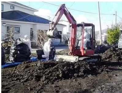
バックホウによる表土剥ぎ取り
