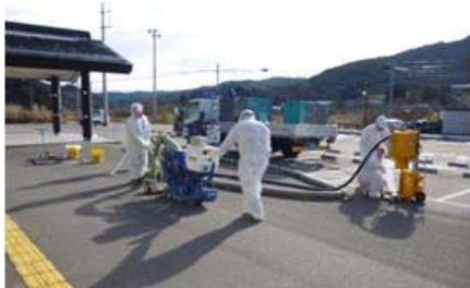
スチールショットブラストによる 舗装表面薄層切削
