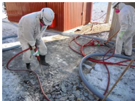
ブレーカーによる舗装撤去
