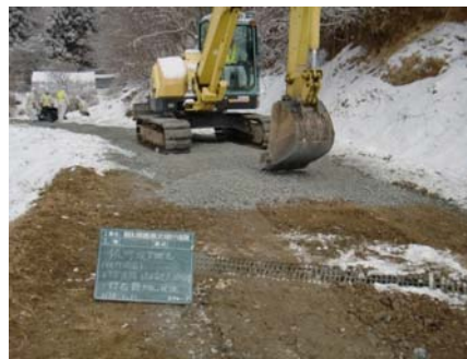
バックホウによるアスファルト舗装撤去⇒フィニッシャ※によるアスファルト舗装打替え
