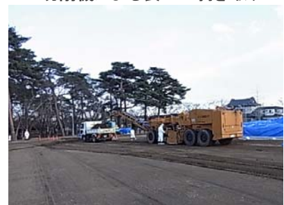
グラウンド: 切削機による表土の剥ぎ取り
