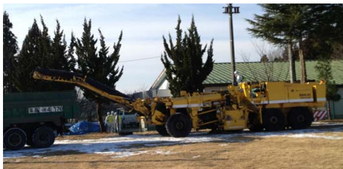
切削機による表土剥ぎ取り(グラウンド)
