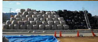
←富岡第二中の一時保管場所 (遮へい土のうを設置中)
