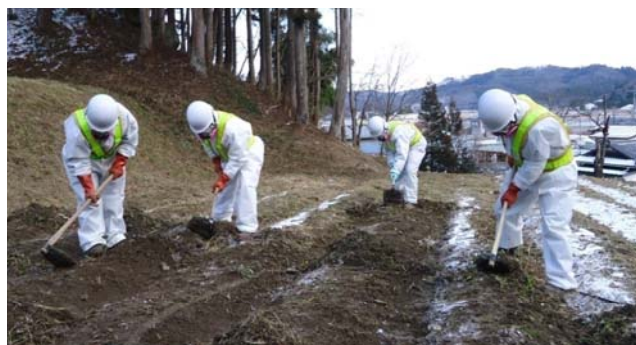
固化材を利用した表土剥ぎ取り
