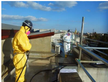
宿泊棟屋上: 高圧水洗浄
