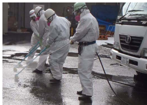
ブラシ掛けによるアスファルト舗装清掃
