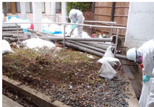
側溝内碎石・透水管の撤去・敷き直し
