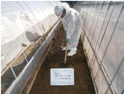
農地: 人力による表土剥ぎ取り
