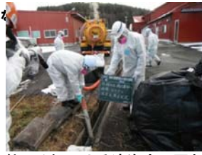
<バキュームカーによる洗浄水の回収>
