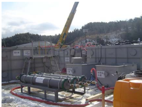
〈排水処理設備〉
