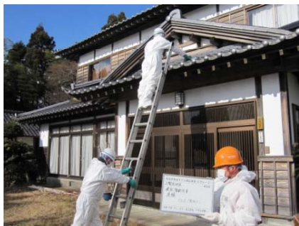
宅地: 人力による屋根の拭き取り
