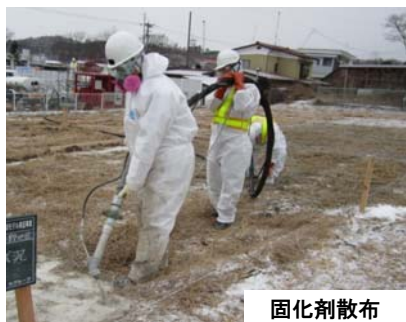
固化材を利用した表土剥ぎ取り
