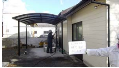
高圧水洗浄による壁面清掃
