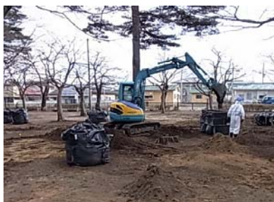
森林: バックホウによる表土の剥ぎ取り
