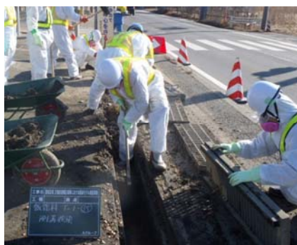
ブラシ掛けによるアスファルト舗装清掃
