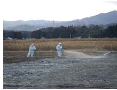
固化材の散布による表土剥ぎ取り
