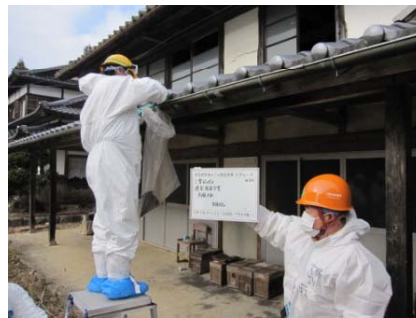
宅地: 人力による雨樋の堆積物除去
