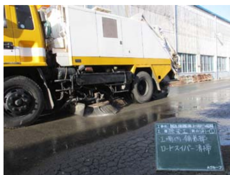
路面清掃車による水洗浄
