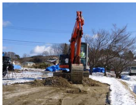
バックホウによる表土剥ぎ取り
