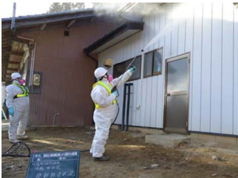
高圧洗浄による壁面清掃
