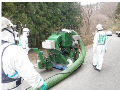
ショットブラストによる舗装面の切削
