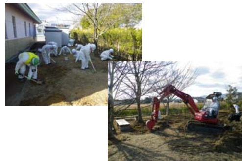
人力及びバックホウによる 表土剥ぎ取り
