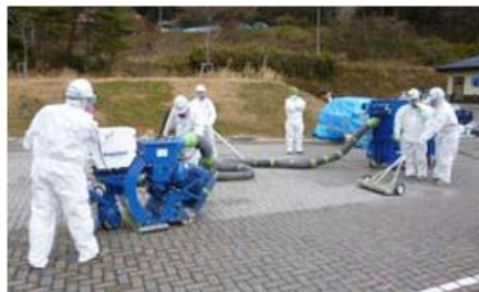
スチールショットブラストによる インターロッキング表面薄層切削
