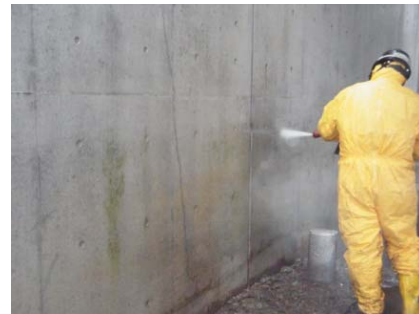
壁: 高圧水洗浄
