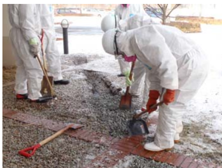
ホットスポット(雨だれ部)碎石の撤去・敷き直し
