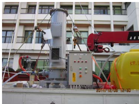
〈高性能フィルター濾過システム〉
