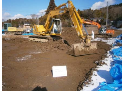
農地: 機械による表土剥ぎ取り
