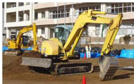
バックホーによる表土剥ぎ取り
