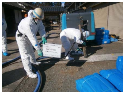
宅地: サンドブラストによる石畳の削り取り
