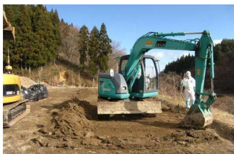
耕作土の剥ぎ取り(ワイパー工法)
