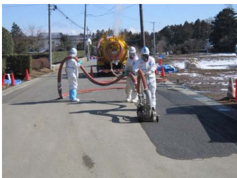
人力による側溝の清掃
