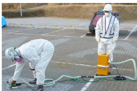
コンクリートカンナによる インターロッキング表面薄層切削
