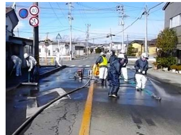
高圧水洗浄による舗装面清掃
