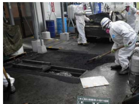
人力によるアスファルト再舗装
