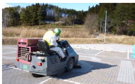
金属ブラシスイーパーによる インターロッキング表面薄層切削
