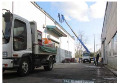
レーザーアブレーション※1によるチェッカープレート面※2の除染
