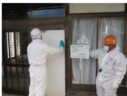
宅地: 人力による土壁の拭き取り
