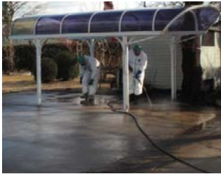
コンクリート土間: 高圧水洗浄
