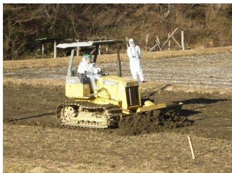
耕作土の剥ぎ取り(ブルドーザー)
