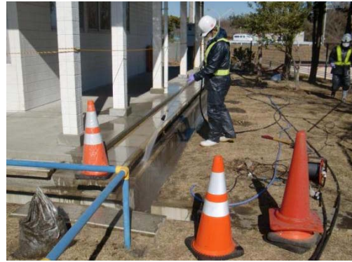
側溝の高圧洗浄
