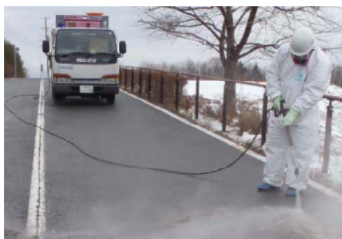
高圧洗浄機によるアスファルト舗装清掃
