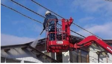
高圧水洗浄による屋根清掃
