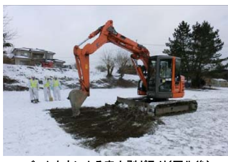
バックホウによる表土剥ぎ取り(固化後)
