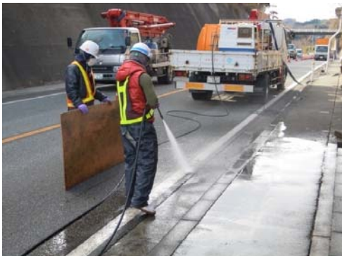
人力による側溝の清掃
