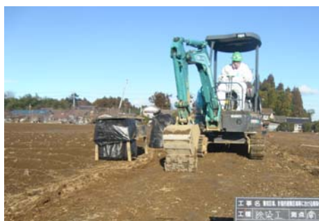
未舗装道路の表土剥ぎ取り
