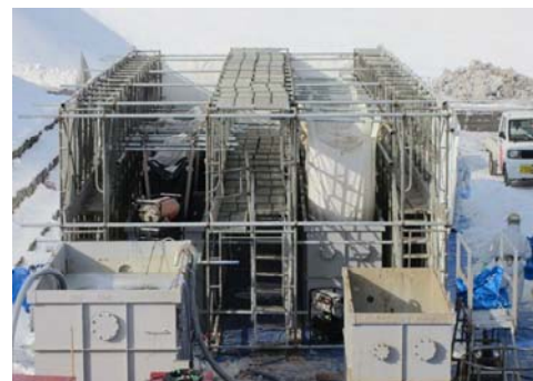
仮設試験設備
