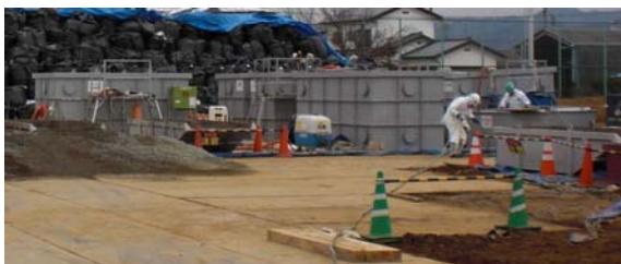
〈排水処理設備〉
