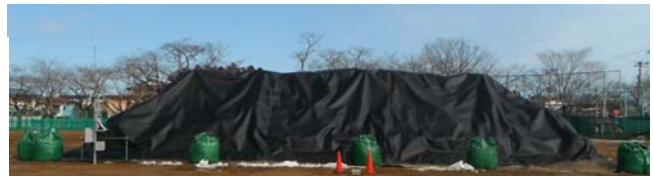
富岡第二中の一時保管場所 (上部遮水シート敷設後)
