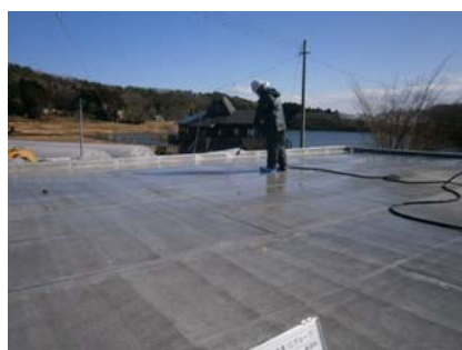
大型建物: 高圧洗浄による屋上清掃
