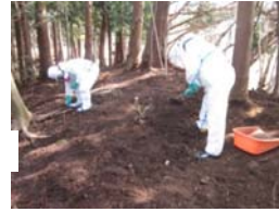
腐葉土層除去と表土剥ぎ取り
