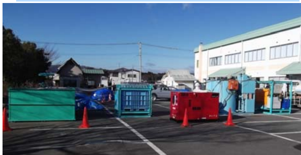
〈水処理設備設置状況〉
