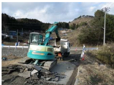
バックホウによるアスファルト舗装撤去⇒フィニッシャ※によるアスファルト舗装打替え
