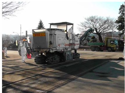
路面切削機による舗装切削
