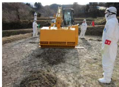
耕作土の剥ぎ取り(ハンマーナイフ工法)
