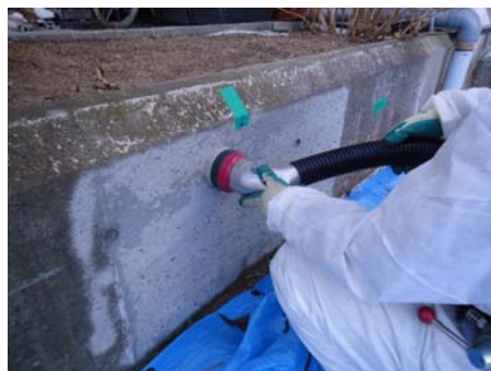
バキュームブラストによる壁面切削
