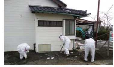
人力による表土剥ぎ取り
