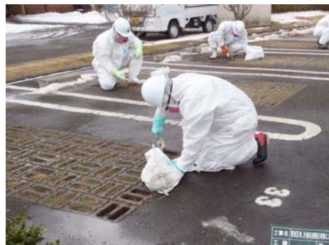
側溝内碎石・透水管の撤去・敷き直し
