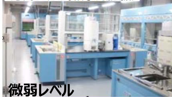
化学分析棟 (地下水バイパス試料等の取扱場所)
