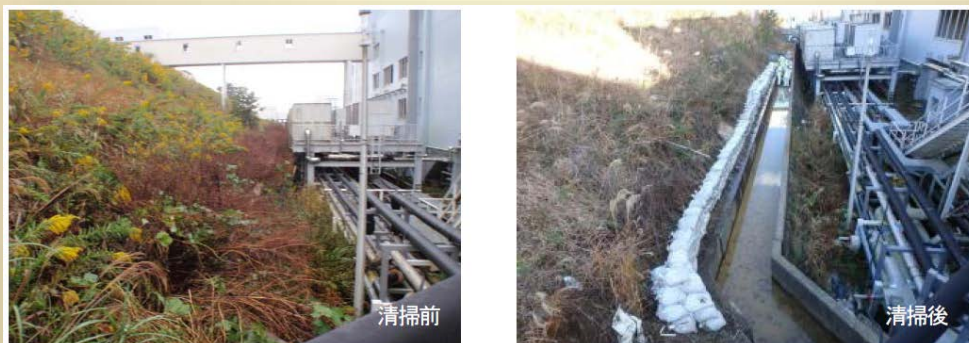
K排水路に係る側溝清掃状況
