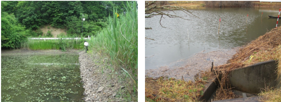
図 4.5-1 実証試験実施場所（ため池）の水生植物の状況 （左図：7月頃、右図：4月頃撮影、大成建設株式会社）
