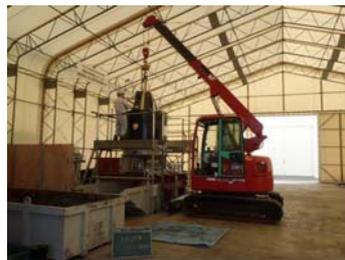
写真3-3 洗浄槽内設置
