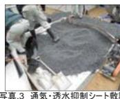
写真.3 通気・透水抑制シート敷設
