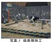
写真.1 吸着層施工
