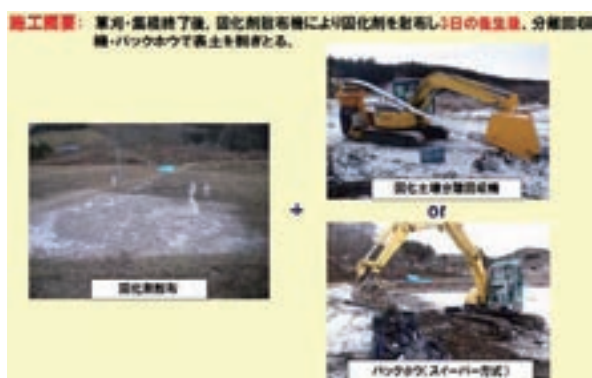
図 4-3-2 固化剤散布による表土剥ぎ取り
