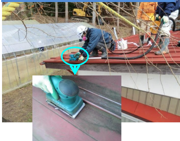
トタン屋根の電動研磨除染
