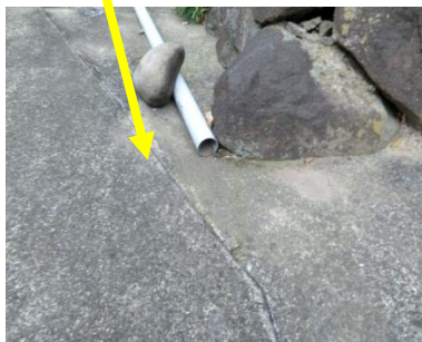
コンクリートの割れ目
