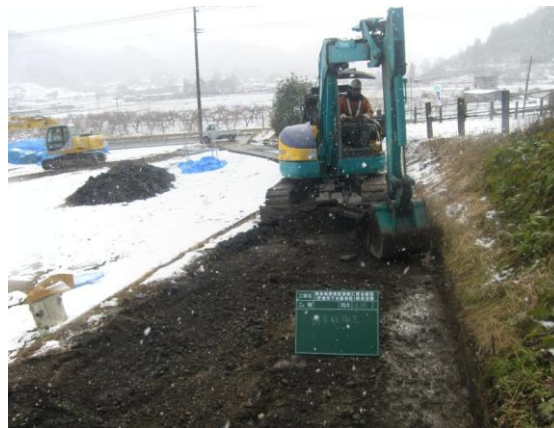
アスファルトの撤去・再舗装
