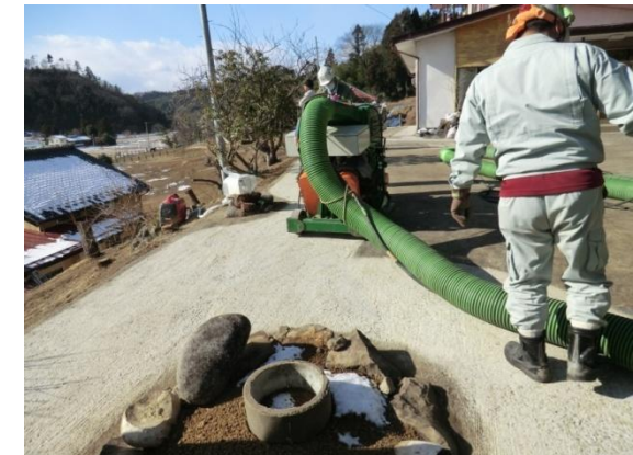
コンクリート敷のブラスト除染
