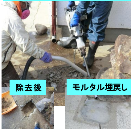
コンクリートの破碎・除去 下部土壌の除去
