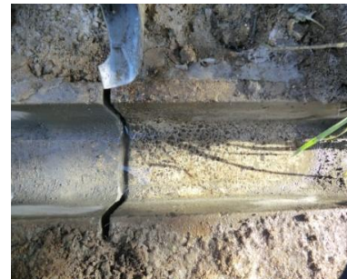
コンクリートの側溝
