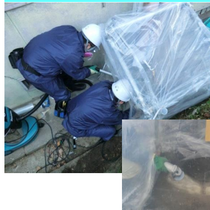
コンクリート表面の研削
