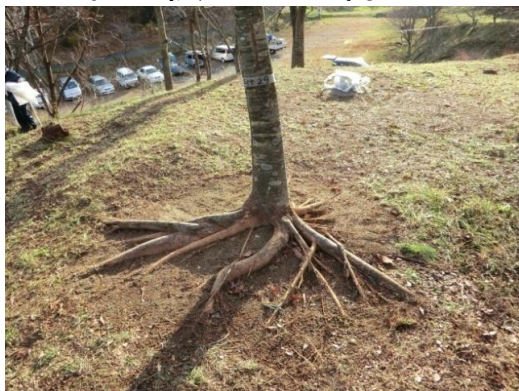
【傾斜地】 木の根元の土除去
