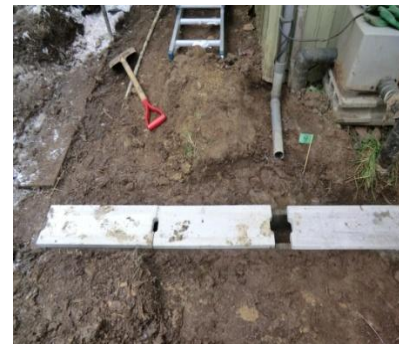
除染後に側溝に蓋を設置
