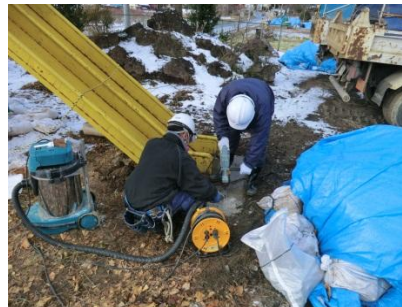
滑り台コンクリート部位
