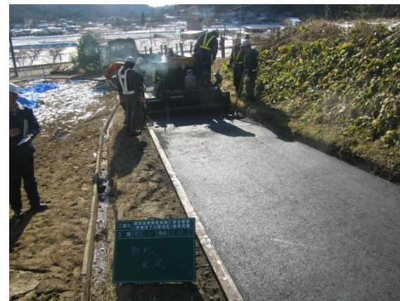
アスファルトの撤去・再舗装
