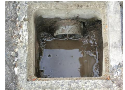
コンクリートの集水マス
