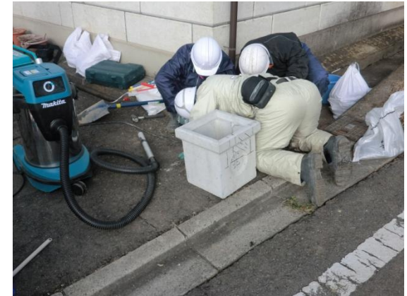
側溝、集水マスの除染
