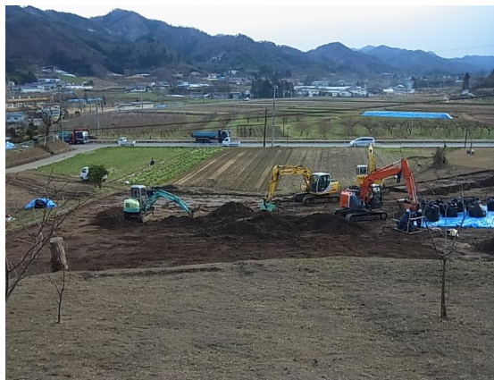
重機による表土除去
