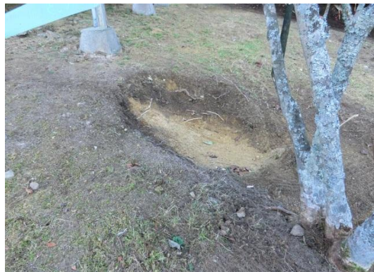
【ロッジ】 雨樋下の土除去
