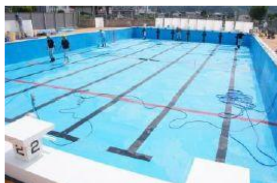
清掃後のプール
