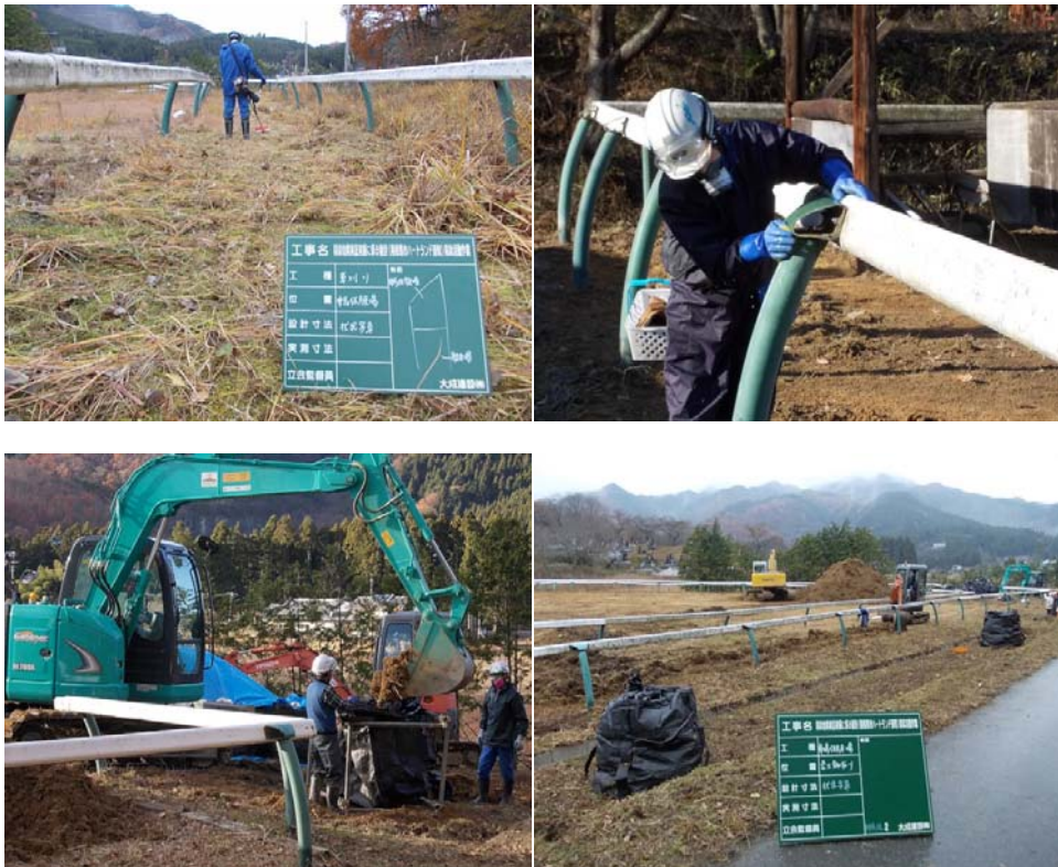
図 3.2.4-12 面的除染の実施状況 11（乗馬体験場の除染）
