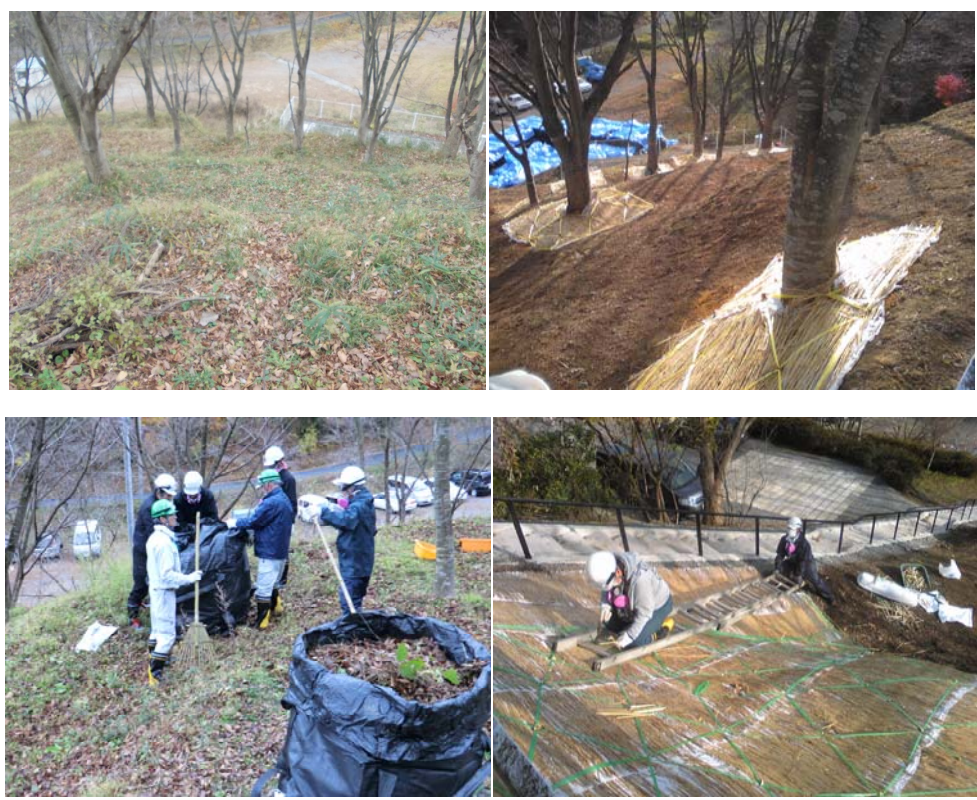
図 3.2.4-10 面的除染の実施状況 9 (傾斜地の除染)
