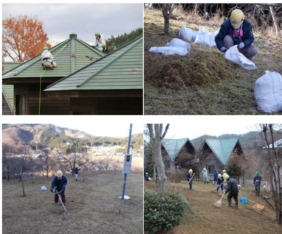
図 3.2.4-8 面的除染の実施状況 7 (ロッジ周囲の建物屋根・庭等の除染)
