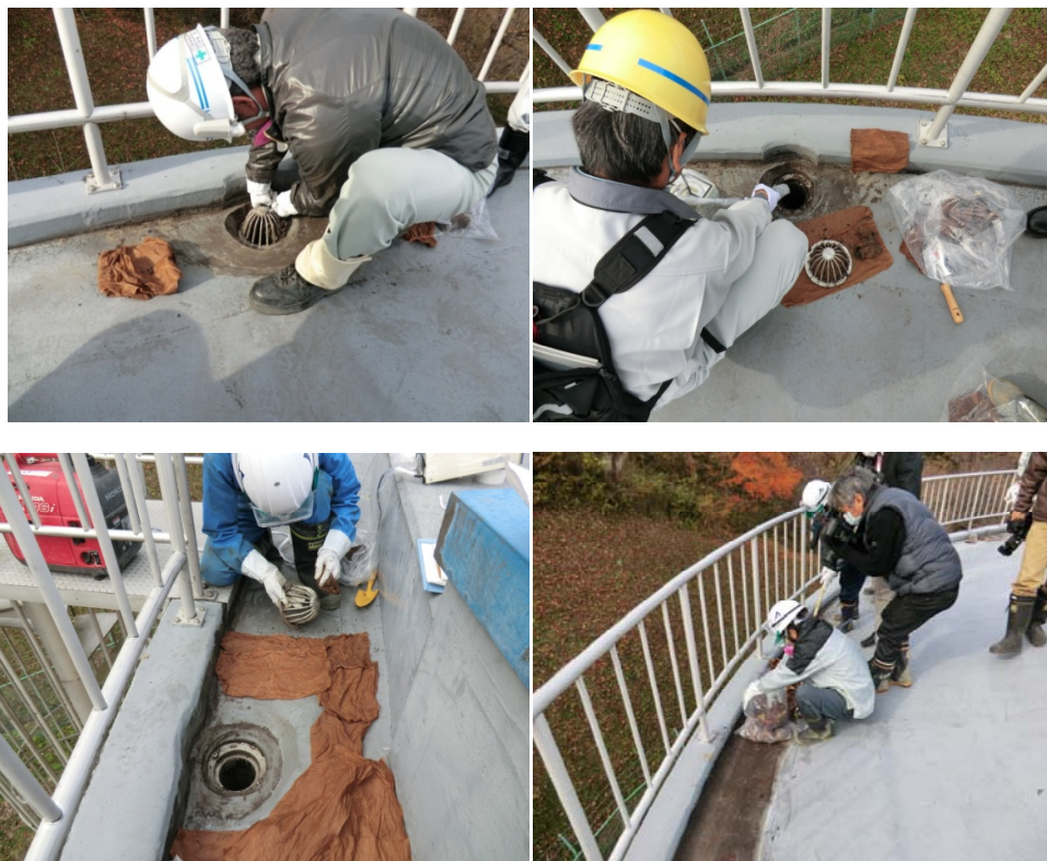
図 3.2.4-5 面的除染の実施状況 4 (給水塔周囲のホットスポットの除去)
