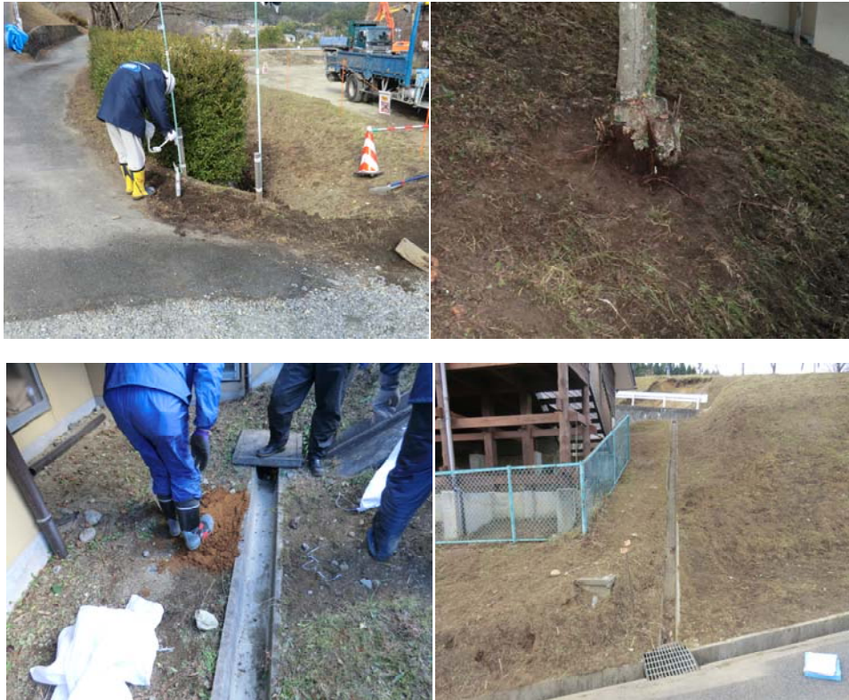
図 3.2.4-3 面的除染の実施状況 2（農業体験実習館周囲のホットスポットの除去）
