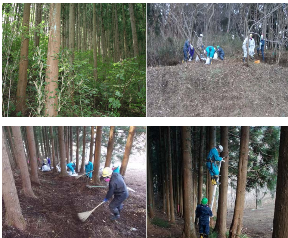
図 3.2.4-14 面的除染の実施状況 13 (森林の除染)
