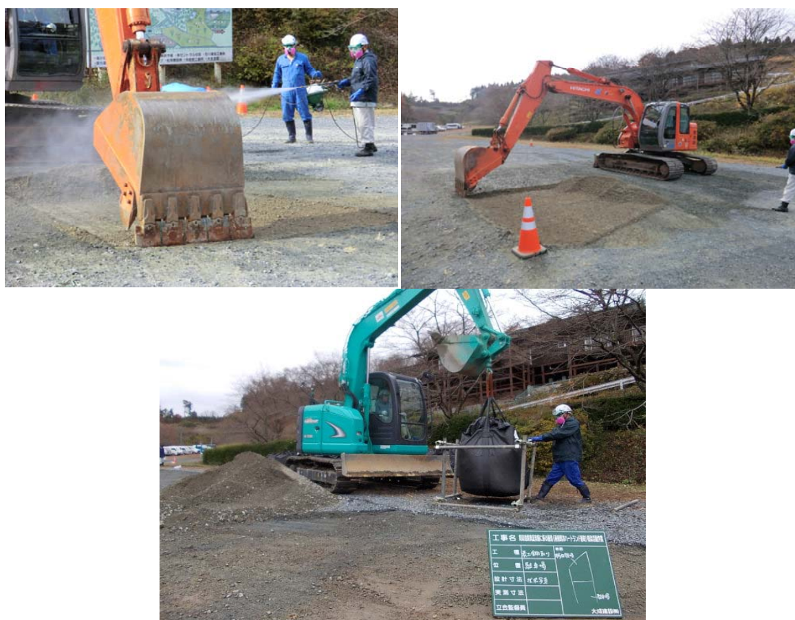
図 3.2.4-2 面的除染の実施状況 1（駐車場の除染）
