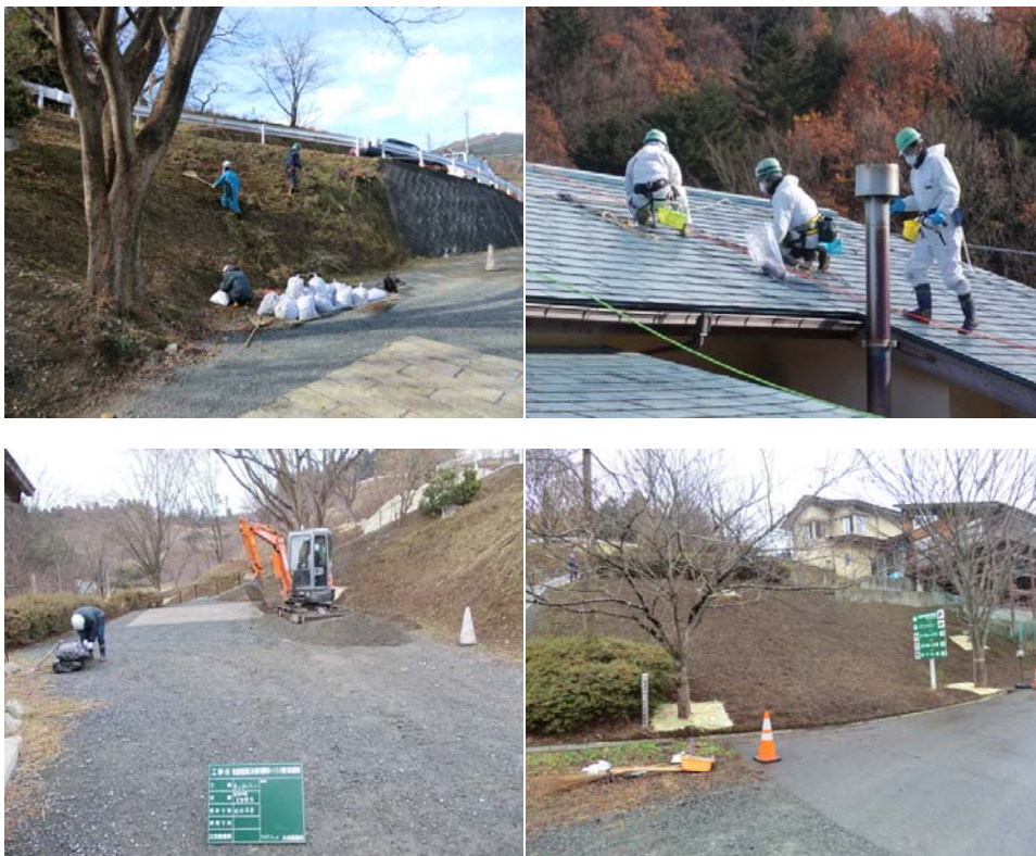
図 3.2.4-4 面的除染の実施状況 3（農業体験実習館及び周囲の除染）
