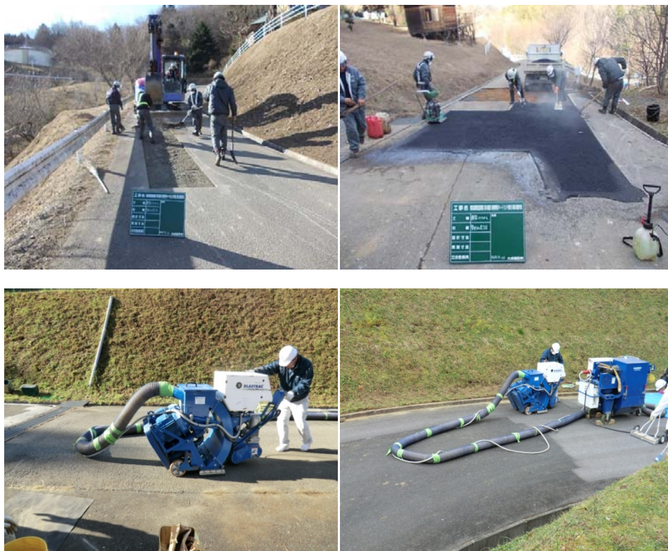
図 3.2.4-13 面的除染の実施状況 12 (道路の除染)
