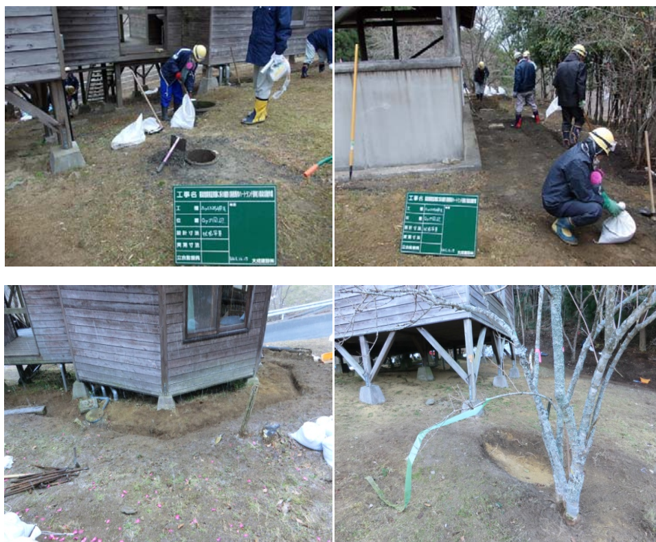
図 3.2.4-7 面的除染の実施状況 6 (ロッジ周囲のホットスポットの除去)
