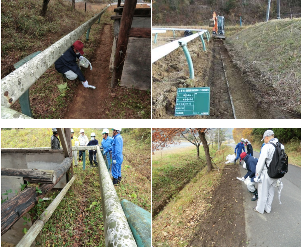
図 3.2.4-11 面的除染の実施状況 10（乗馬体験場のホットスポットの除去）
