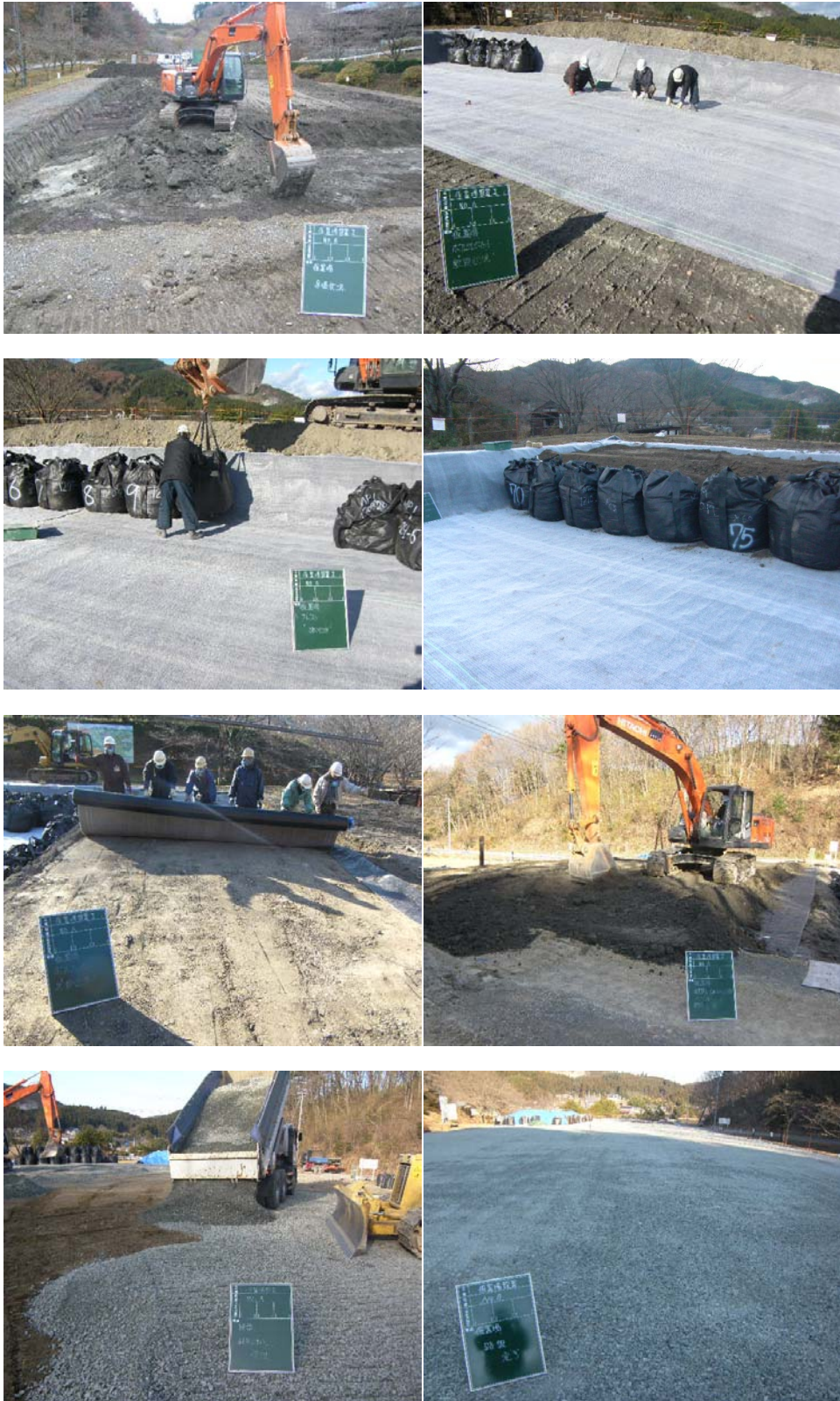
図 3.2.4-15 面的除染の実施状況 14 (除去物の一時保管)
