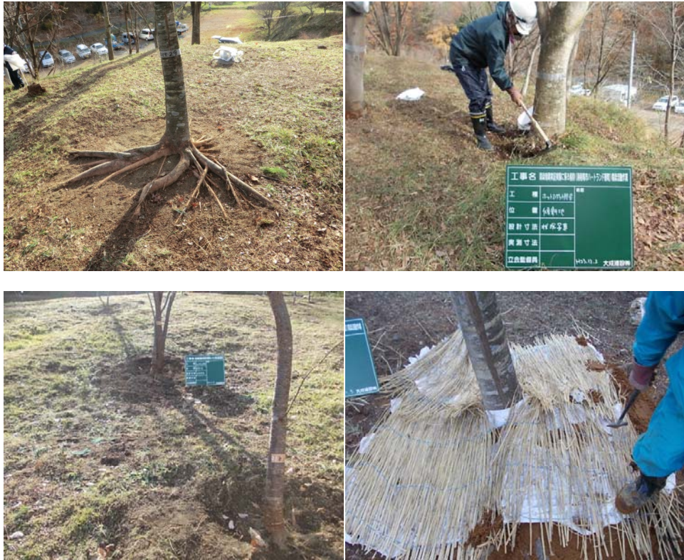
図 3.2.4-9 面的除染の実施状況 8 (傾斜地のホットスポットの除去)
