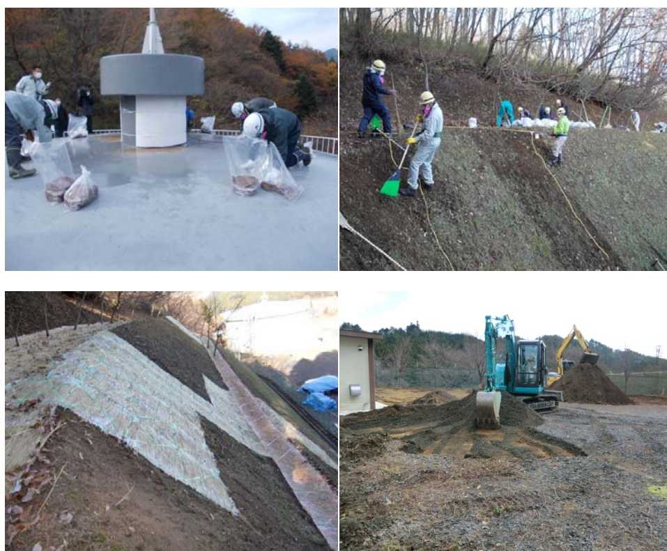
図 3.2.4-6 面的除染の実施状況 5 (給水塔周囲の屋上・庭等の除染)
