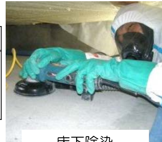
床下除染 (グライダ-工法)
