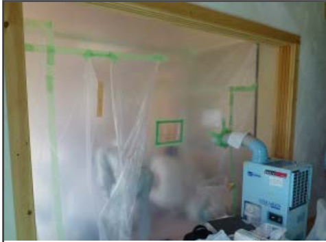
クリーンハウス設置
