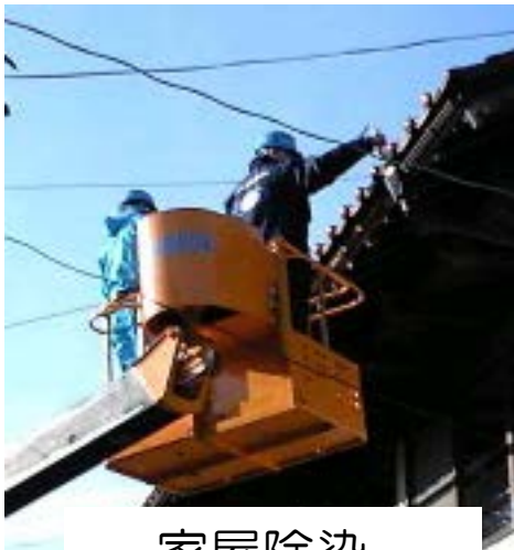
家屋除染 (高圧水洗浄)
