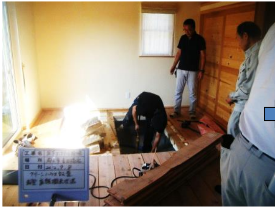
床下開口部の設置
