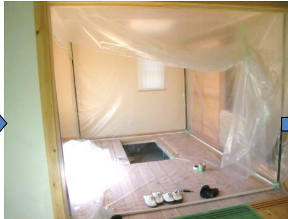
クリーンハウスの組立
