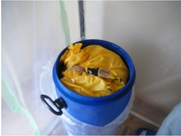
除染廃棄物の充填容器詰め
