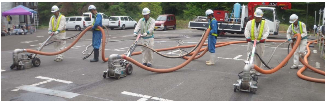
中通りでは最大3台(作業効率3倍)まで利用可能であることを確認
