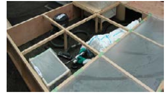
図 7-8 モックアップ試験状況
