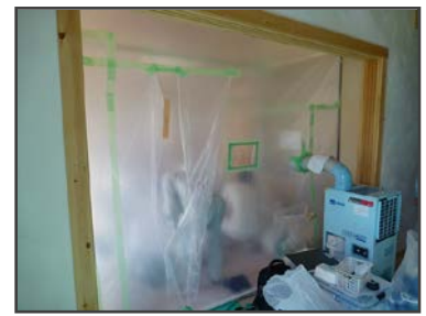
図 7-6 クリーンハウス外観
