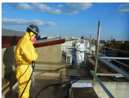
宿泊棟屋上: 高圧水洗浄
