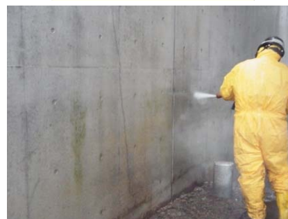
壁: 高圧水洗浄
