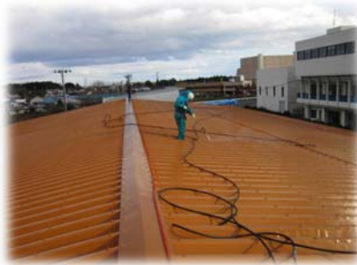
屋根の高圧洗浄
