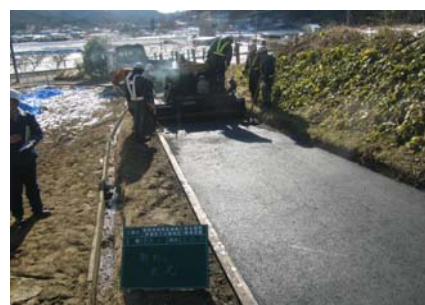
アスファルトの撤去・再舗装
