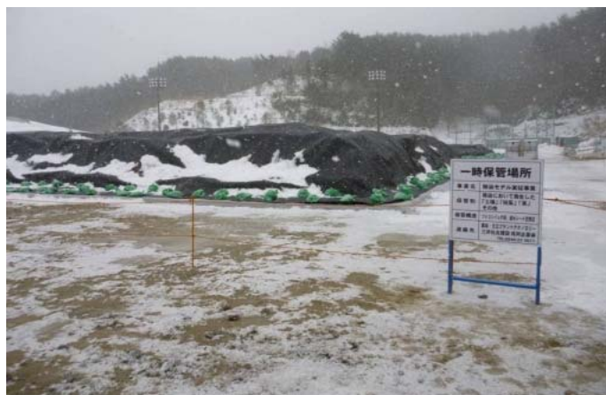
除去土壌の保管場所である旨と緊急時の連絡先を記入した掲示板を設置
