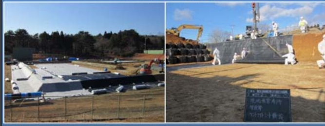
③ 遮水工敷設
