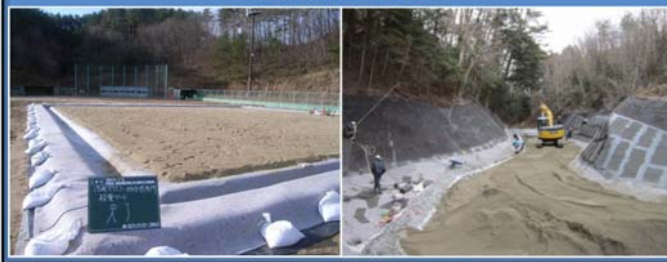
⑤ 保護土敷設
