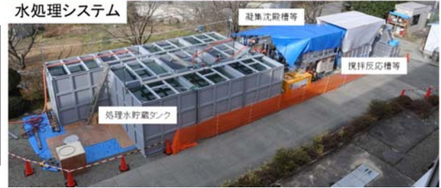
水処理システム
