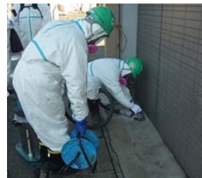
コンクリート(たたき): 表面研磨機
