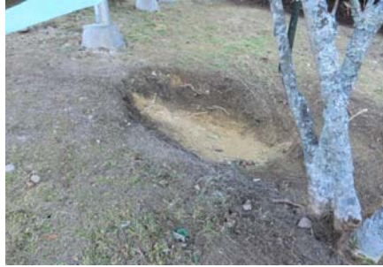
【ロッジ】 雨樋下の土除去
