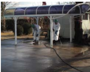
コンクリート(たたき): 高圧水洗浄
