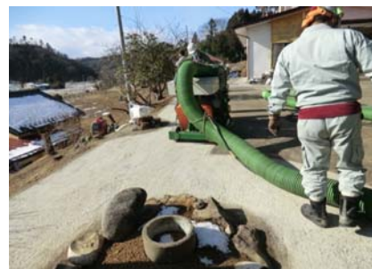
コンクリート敷のプラスト除染
