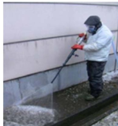
路面・建物の除染
