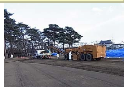
グラウンド: 切削機による表土の剥ぎ取り
