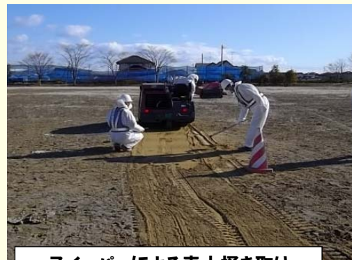
スーパーによる表土掻き取り
