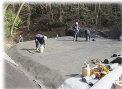
上部遮水シート工
