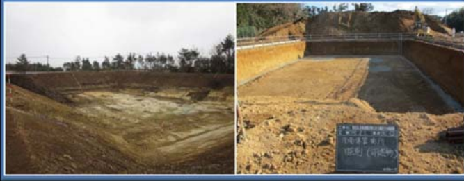
① 造成(伐採・掘削)
