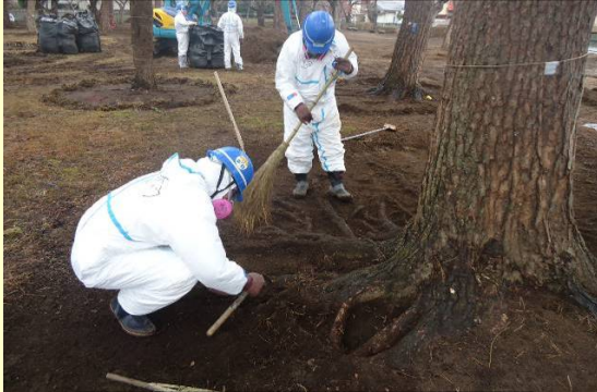
木の根周りの剥ぎ取り(人力)
