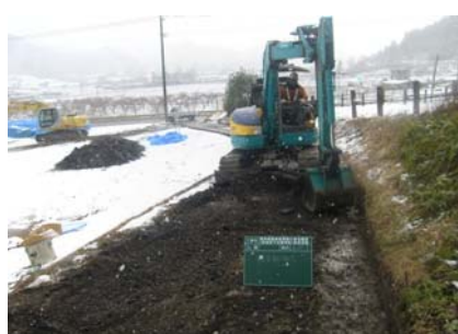
アスファルトの撤去・再舗装
