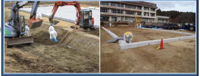
② 堰堤構築
