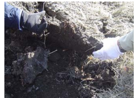
固化剤散布後の剥ぎ取り
