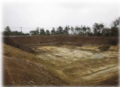
造成(伐採・掘削)
