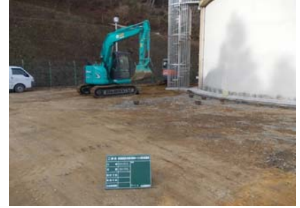
【給水塔】 重機による表土除去
