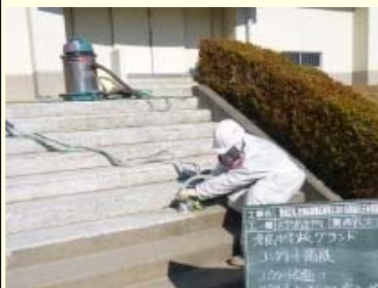
コンクリート階段
