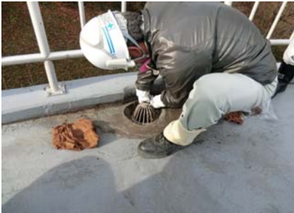
【給水塔】 排水口の堆積物除去
