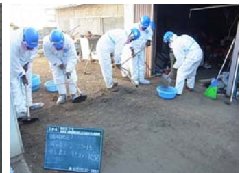
庭: 表土の剥ぎ取り
