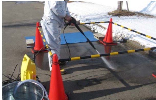
ナノバブル水によるコンクリート洗浄
