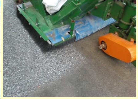
施工後の接写
