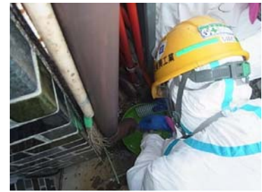
雨樋(縦樋): 高圧水洗浄、吸引
