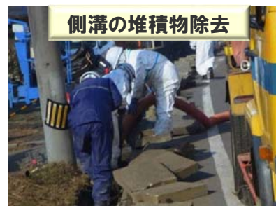
機能回復車による高圧水洗浄
