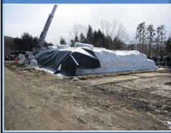
⑦ 上部遮水シート工
