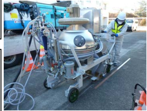
団地内舗装面の除染作業
