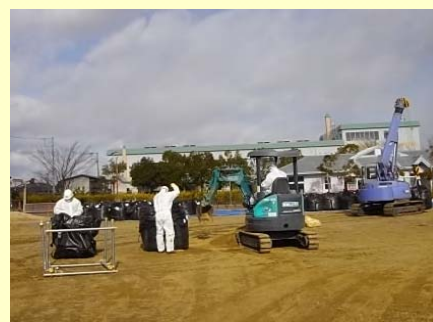
除去土壌詰込状況
