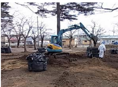
バックホウによる表土の剥ぎ取り
