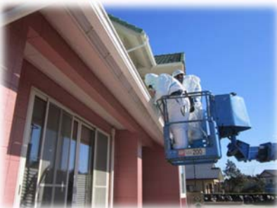
高所作業車による雨樋の拭き取り
