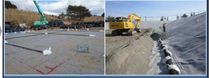
④ 浸出水集排水管敷設
