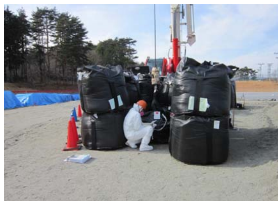
除去物の表面線量率測定状況
