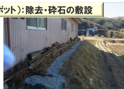
側溝の堆積物除去
