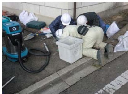
側溝、集水マスの除染
