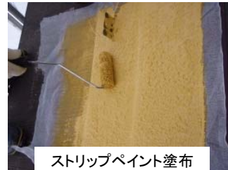
剥離除染の原理
