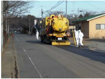
排水性舗装機能回復車による高圧水洗浄
