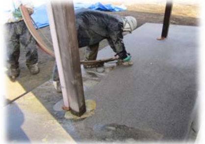
宅地(舗装面)の超高圧水切削
