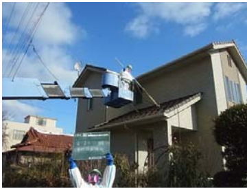
屋根: 水洗浄、ブラシ洗浄
