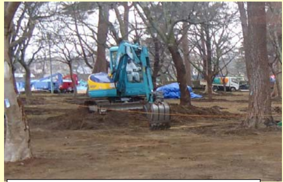
広いエリアの剥ぎ取り(バックホウ)
