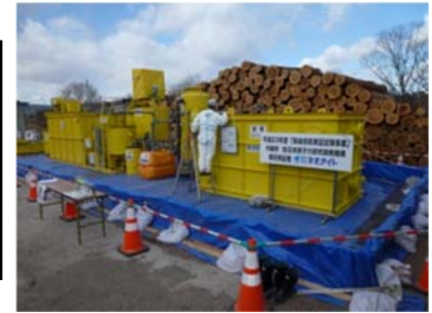
除染設備全体
