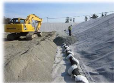
浸出水集排水管敷設
