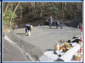
⑧ 上部遮水シート工
