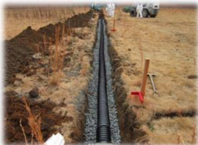
地下水集排水管敷設
