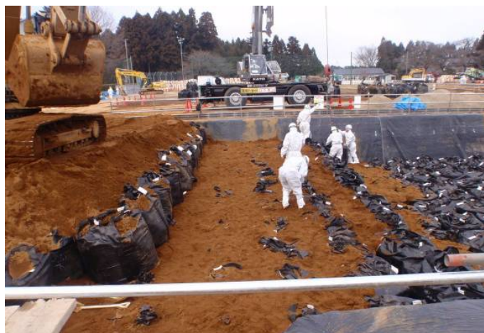
図 3.4-6 フレキシブルコンテナ間の間詰め状況
