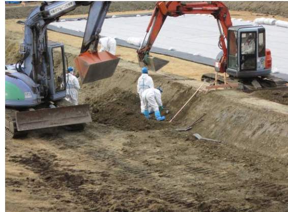
図 3.4-5 周辺堰堤を大きくする方法
