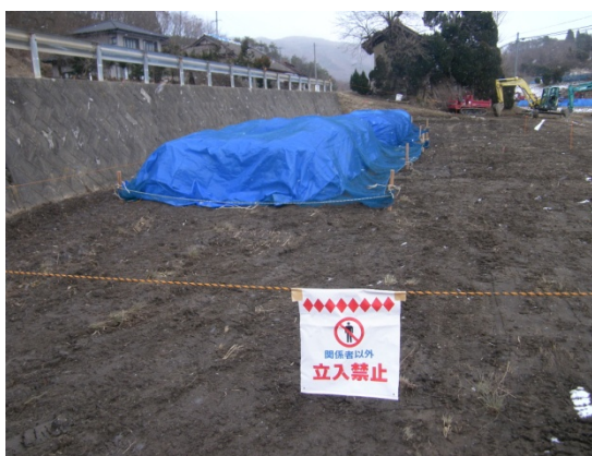
図 3.3-2 一時集積所除去物保管事例①
