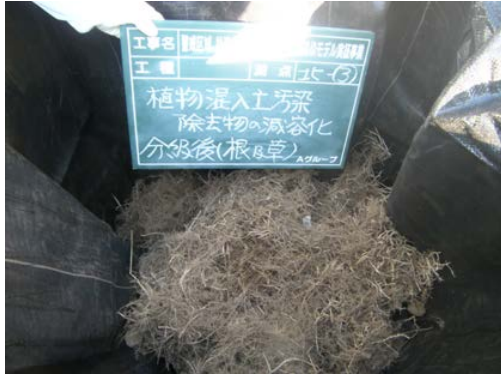
分別後の根等の状況
