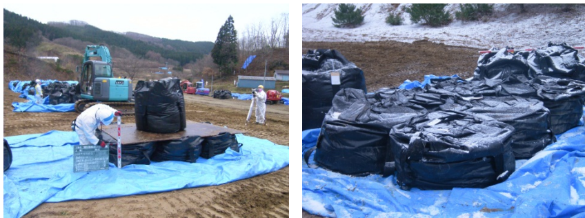
図 2.4.2(3)-6 重量物積載による減容化の概要
