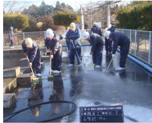
図 2.4.2(1)①(b) II-25 プールサイド除染状況 (コンクリート打ちっばなし)
