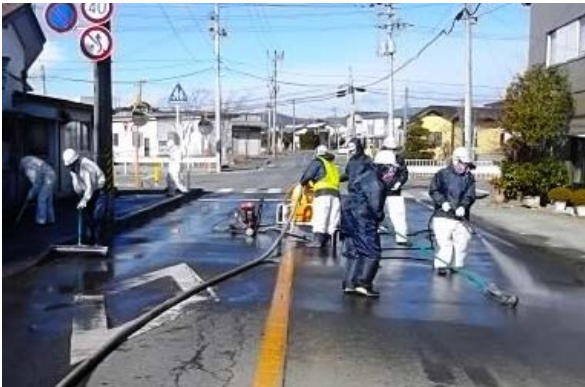
e) 超高压水洗浄機による切削
