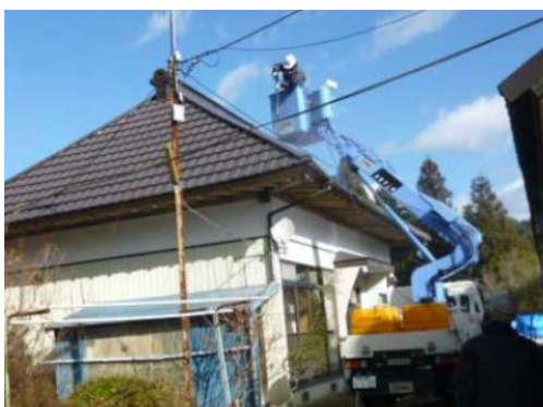
図 2.4.2(1)①(b) I-2 高圧水洗浄実施状況
