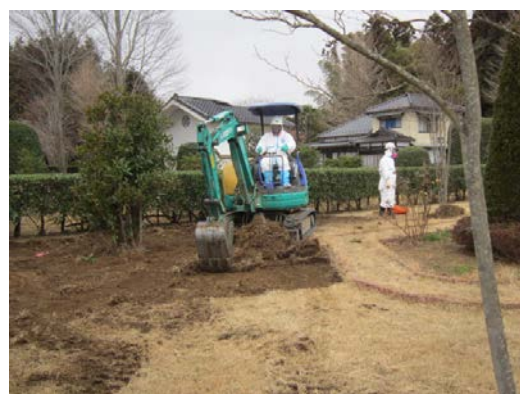
図 2.4.2(1)①(b)Ⅰ-19 小型バックホウによる芝の剥ぎ取り状況
