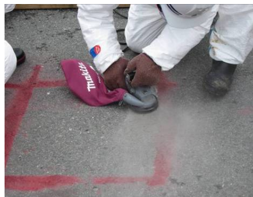
b) 集塵サンダーを用いて舗装面を切削
