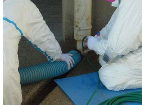
図 2.4.2(1)①(b)Ⅱ-7 高圧水洗浄実施状況
