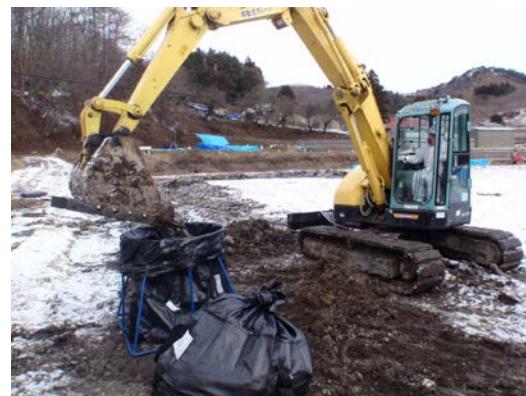
図 2.4.2(1)①(b) III-10 表土剥ぎ取り状況
