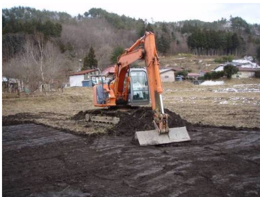
図 2. 4. 2(1)①(b)Ⅲ-14 天地返し (表層土剥ぎ取り作業)
