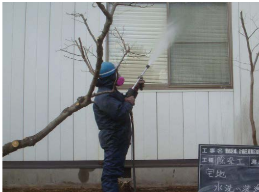
図 2.4.2(1)①(b) I-8 高圧水洗浄実施状況
