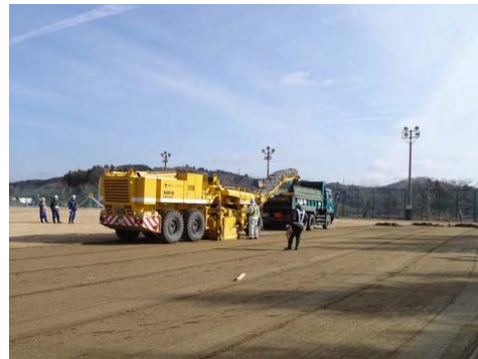
図 2.4.2(1)①(b) II-15 路面切削機実施状況
