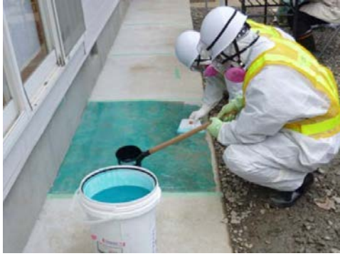
図 2. 4. 2(1)①(b) I -22 剥離剤塗布実施状況 図 2. 4. 2(1)①(b) I -23 ブラッシング実施状況
