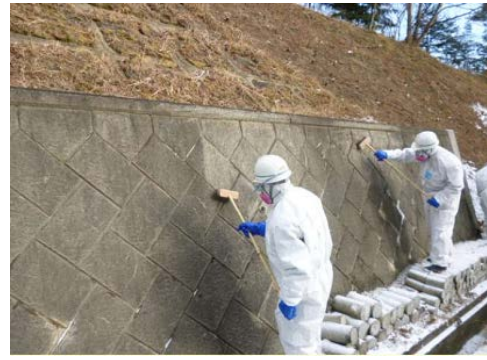
図 2. 4. 2(1)①(b) I -22 剥離剤塗布実施状況 図 2. 4. 2(1)①(b) I -23 ブラッシング実施状況
