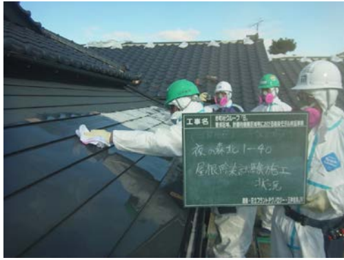
図 2.4.2(1)①(b) I-4 拭き取り実施状況 図 2.4.2(1)①(b) I-5 剥離剤剥離実施状況
