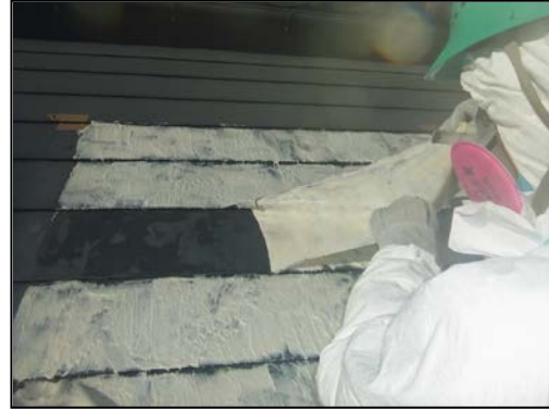
図 2.4.2(1)①(b) I-4 拭き取り実施状況 図 2.4.2(1)①(b) I-5 剥離剤剥離実施状況
