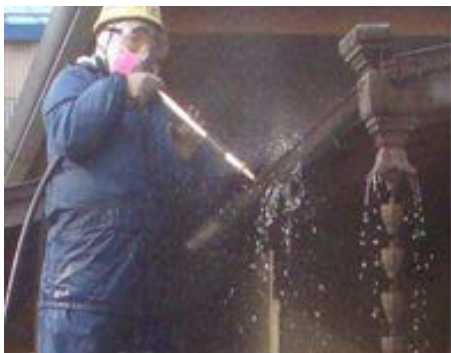
図 2.4.2(1)①(b) I-6 高圧水洗浄実施状況 図 2.4.2(1)①(b) I-7 拭き取り実施状況
