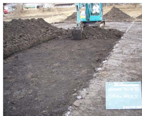
図 2. 4. 2(1)①(b)Ⅲ-15 天地返し (下層土掘削作業)
