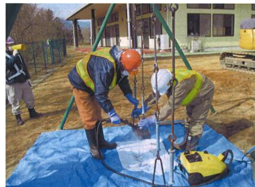
図 2.4.2(1)①(b) II-21 高圧スチーム実施状況
