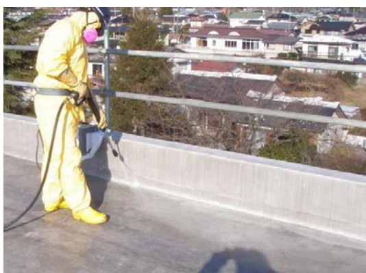
図 2.4.2(1)①(b)Ⅱ-3 高圧水洗浄実施状況
