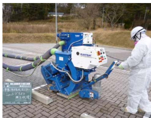
図 2.4.2(1)①(b)Ⅱ-10 ショットブラスト（鉄球）実施状況
