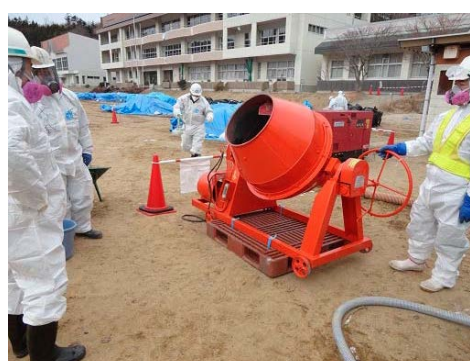
図 2.4.2(1)①(b) I-17 砕石の洗浄状況
