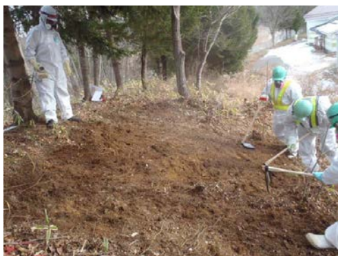
人力による法面表土剥ぎ取り状況
