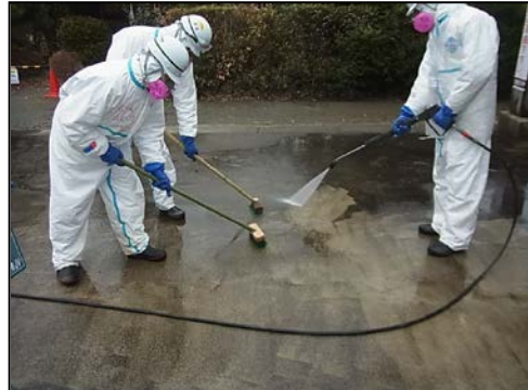
図 2. 4. 2(1)①(b) I -24 高圧水洗浄実施状況 図 2. 4. 2(1)①(b) I -25 高圧水洗浄+ブラッシング実施状況
