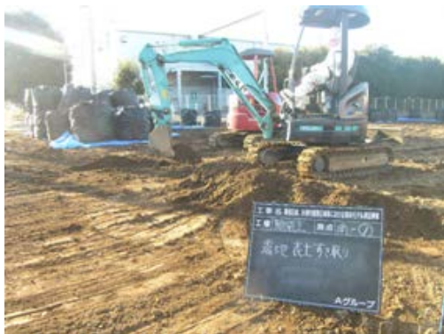
図 2.4.2(1)①(b) III-5 表土剥ぎ取り (バックホウ)
