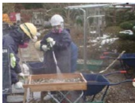
図 2.4.2(1)①(b) I-15 高圧水洗浄実施状況
