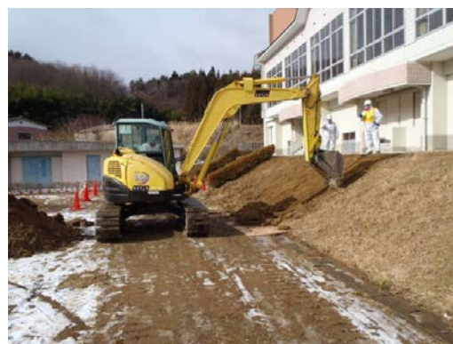
図 2.4.2(1)①(b) II-22 人力剥ぎ取り実施状況 図 2.4.2(1)①(b) II-23 バックホウ剥ぎ取り状況
