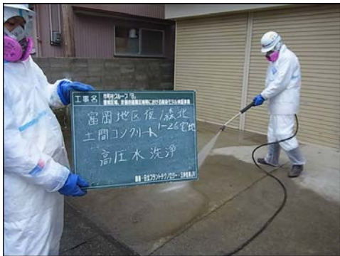
図 2. 4. 2(1)①(b) I -24 高圧水洗浄実施状況 図 2. 4. 2(1)①(b) I -25 高圧水洗浄+ブラッシング実施状況
