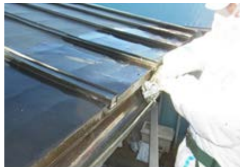
図 2.4.2(1)①(b) I-6 高圧水洗浄実施状況 図 2.4.2(1)①(b) I-7 拭き取り実施状況
