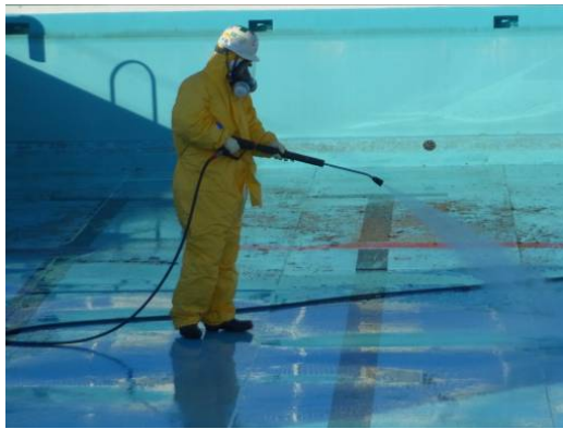
図 2.4.2(1)①(b) II-24 プール槽除染状況 (防水塗装処理)
