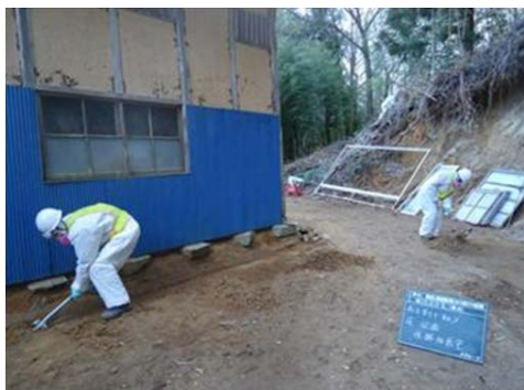
図 2.4.2(1)①(b) I-11 人力剥ぎ取り状況
