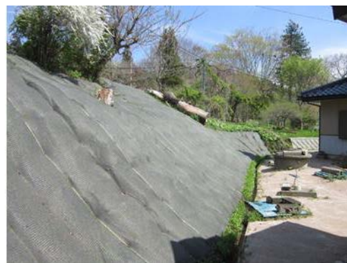
法面保護シートの例
