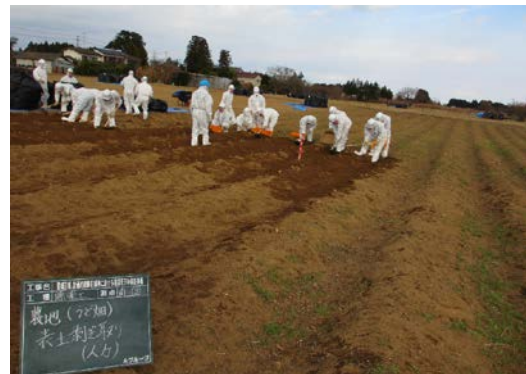
図 2.4.2(1)①(b) III-6 人力による表土剥ぎ取り
