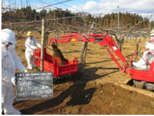
図 2.4.2(1)①(b) III-7 果樹園での表土剥ぎ取り
