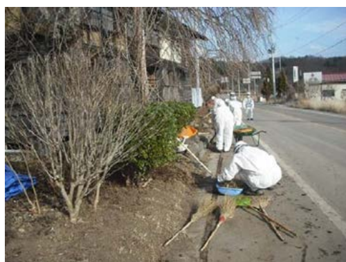
図 2.4.2(1)①(b)Ⅰ-21 庭木下の土壌剥ぎ取り状況
