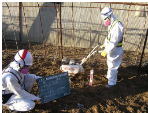
図 2.4.2(1)①(b)Ⅲ-17 小型耕運機による 攪拌耕 (人力)
