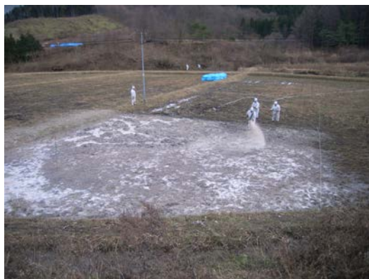
図 2.4.2(1)①(b) III-9 固化剤散布状況
