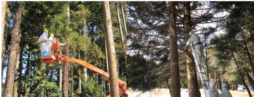
(3) 枝打ち (高所作業車) (4) 枝打ち (人力)
