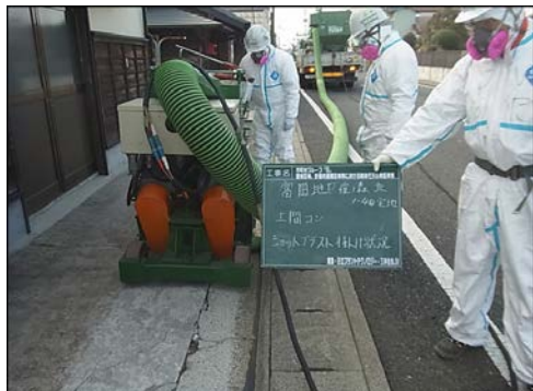
図 2. 4. 2(1)①(b) I -26 図 2. 4. 2(1)①(b) I -27 集塵サンダー実施状況 ショットブラスト実施状況
