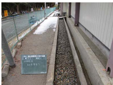
図 2.4.2(1)①(b) I-16 洗浄後玉石の敷均し状況
