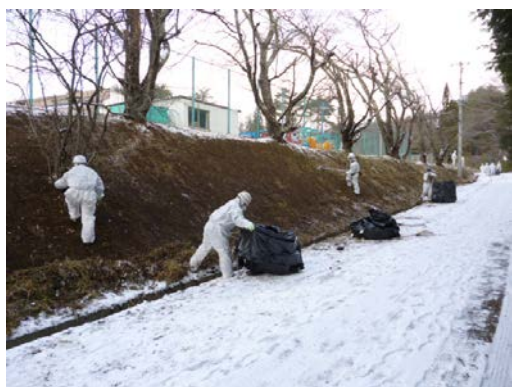
図 2.4.2(1)①(b) II-22 人力剥ぎ取り実施状況 図 2.4.2(1)①(b) II-23 バックホウ剥ぎ取り状況
