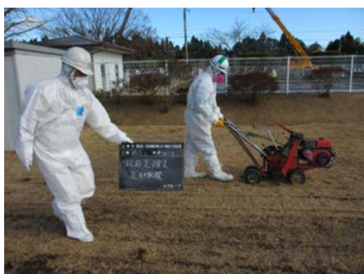
図 2.4.2(1)①(b)Ⅰ-18 ソッドカッターによる芝の深刈り状況
