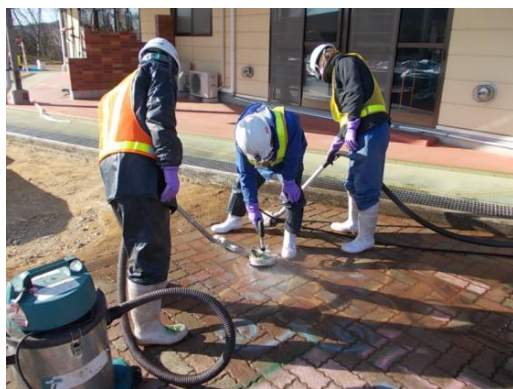
図 2.4.2(1)①(b)Ⅱ-8 回収型高圧水洗浄実施概要
