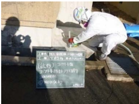
図 2. 4. 2(1)①(b) I -26 図 2. 4. 2(1)①(b) I -27 集塵サンダー実施状況 ショットブラスト実施状況
