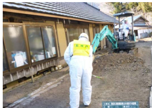
図 2.4.2(1)①(b) I-12 バックホウ剥ぎ取り状況
