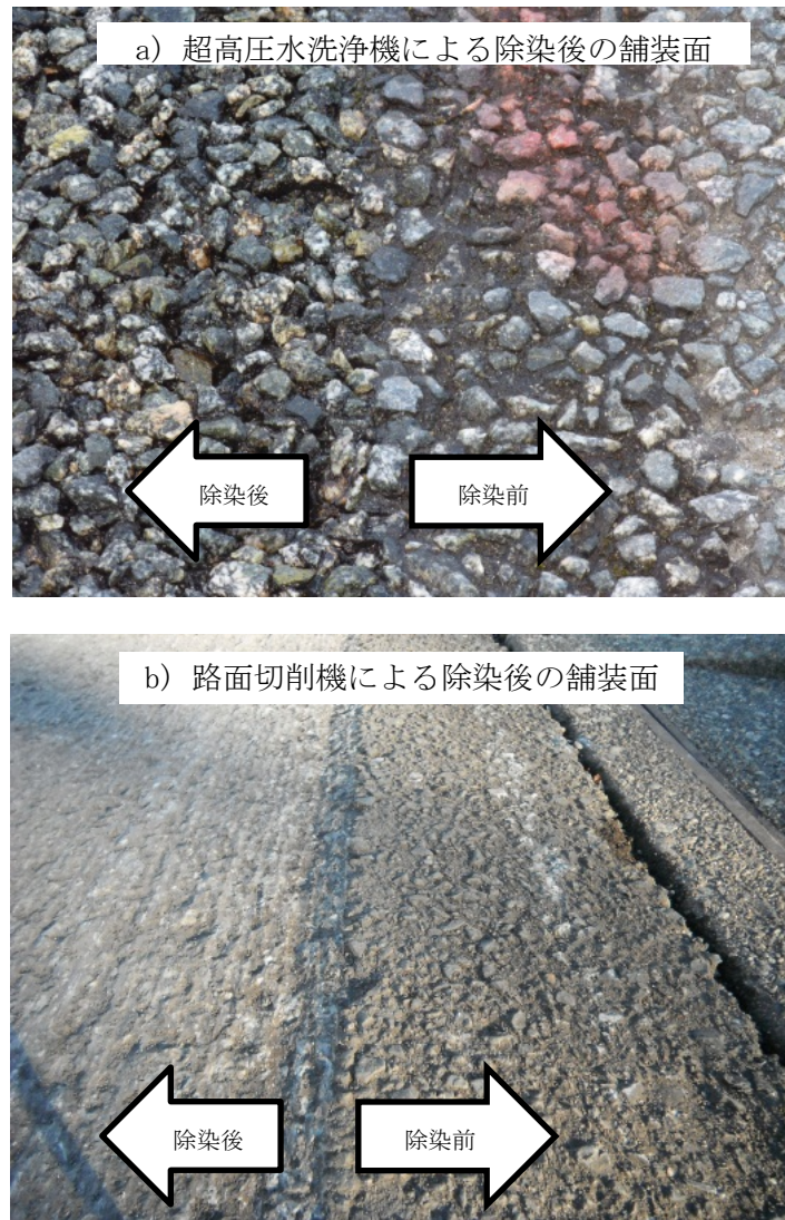
図 2.4.2(1)①(b)IV-8 除染後のアスファルト舗装面
