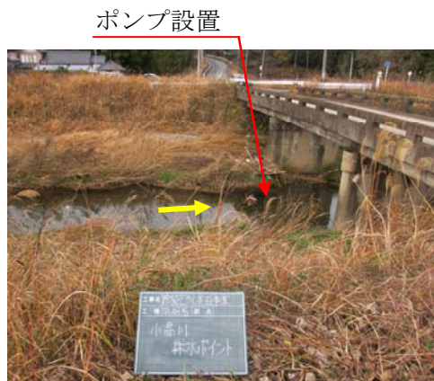
〈取水箇所の状況〉
