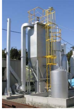
排ガス処理装置例
