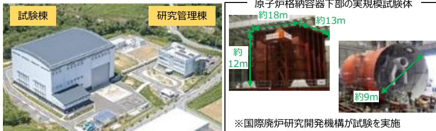
原子炉格納容器下部の実規模試験体
