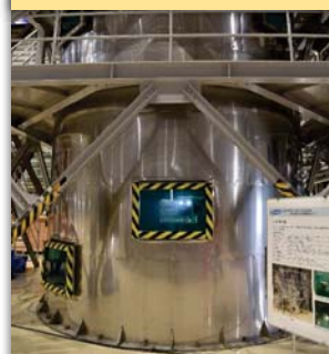
ロボット試験用水槽 (直径 4.5m、水深 5.0m)
